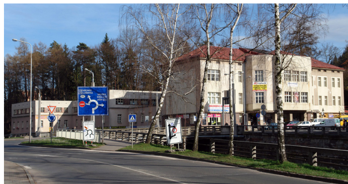
Bývalá Etrichova přádelna juty v Trutnově, dnes centrum obchodů a služeb
