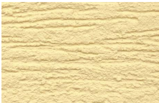
Obr. 27 Struktura rýhované omítky [26]
