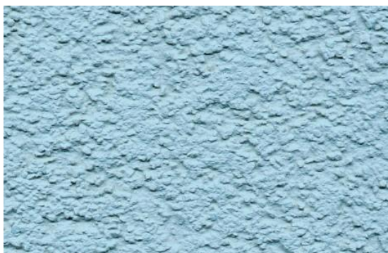
Obr. 28 Struktura roztírané omítky [26]
