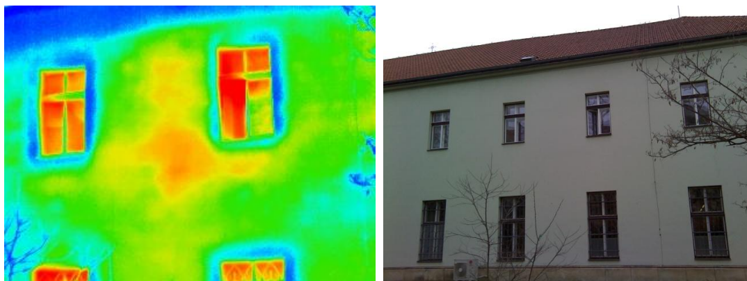
Obrázek 39 – Severní fasáda staré budovy
