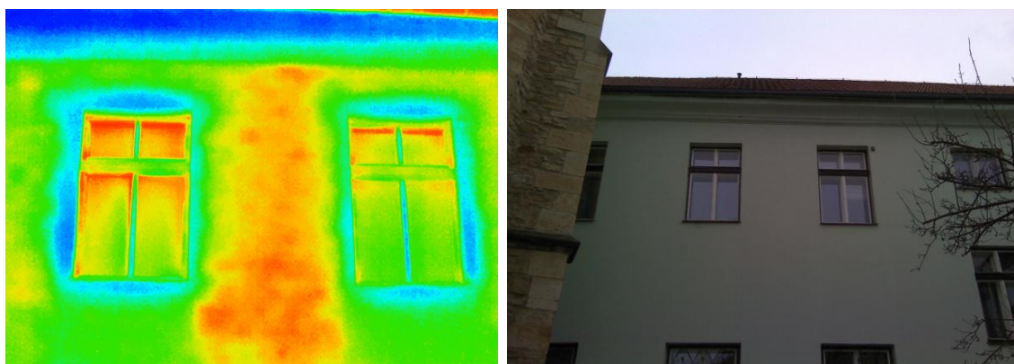
Obrázek 40 – Severní fasáda staré budovy (potrubí systému vytápění)
