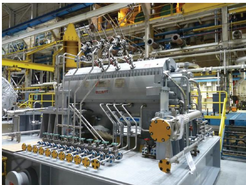
Obrázek 22: Umístění trysek - Elliott Group [6]
