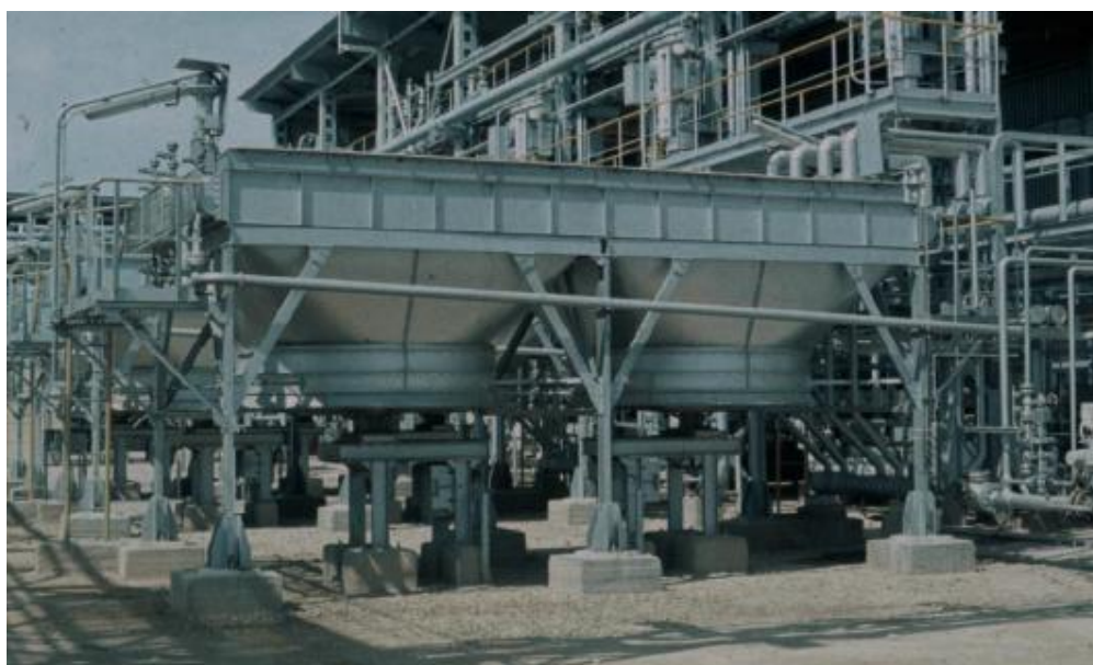
Obrázek 13: Vzduchový chladič, nucené chlazení ventilátory [4]
