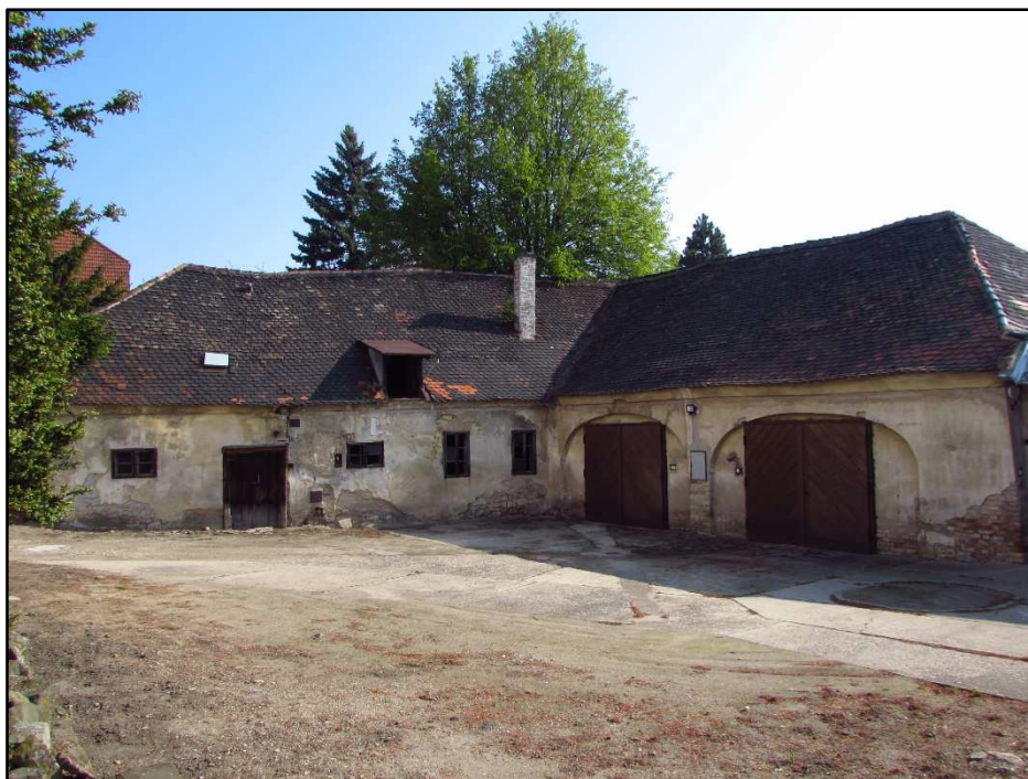
Obr. 15: Pohled na zděný objekt bývalých stájí z hospodářského dvora
