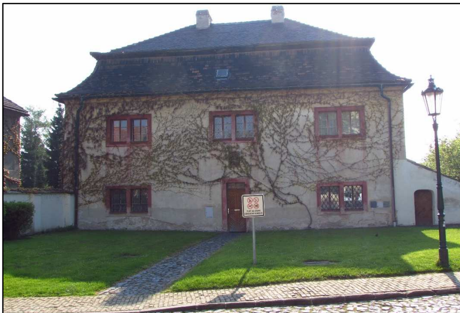
Obr. 9: Pohled na průčelní stranu biskupského domu
