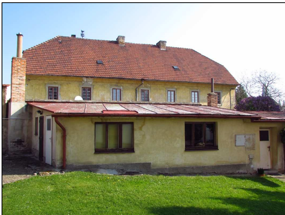
Obr. 17: Zděný objekt č. 4a určený architektonickou studií k odstranění
