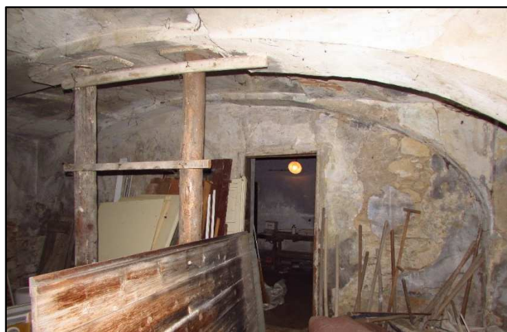
Obr. 16: Ukázka stavebně technického stavu, západní místnost severního křídla zděného objektu bývalých stájí
