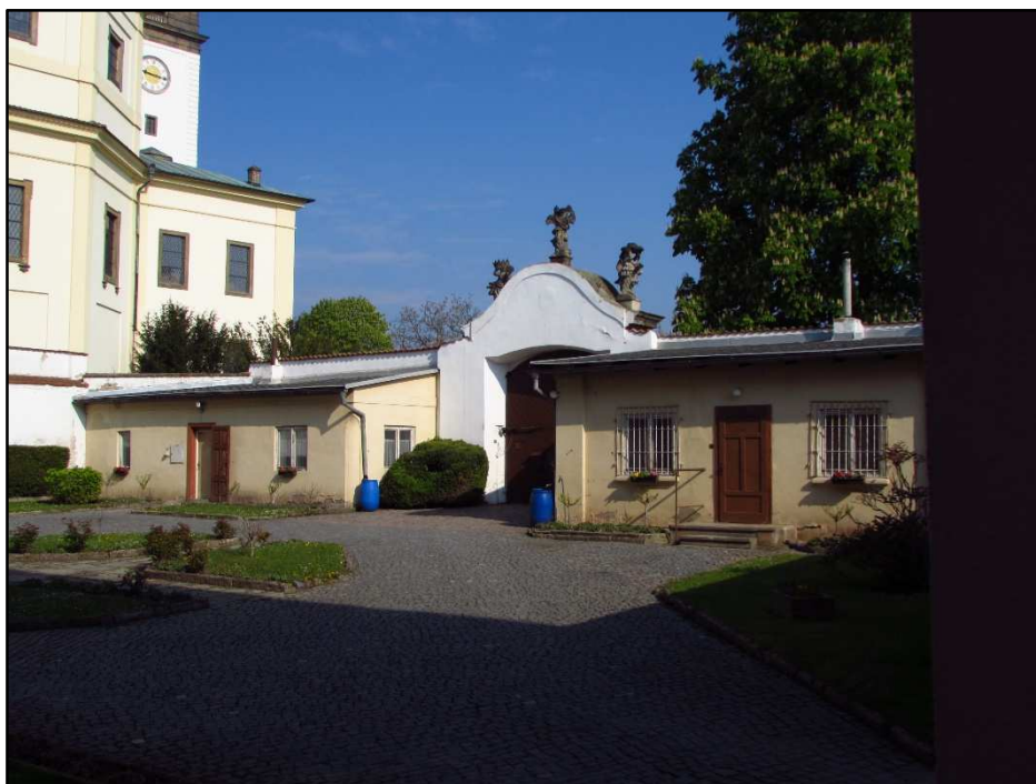
Obr. 14: Pohled na zděné hospodářské objekty č. 1 a 2
