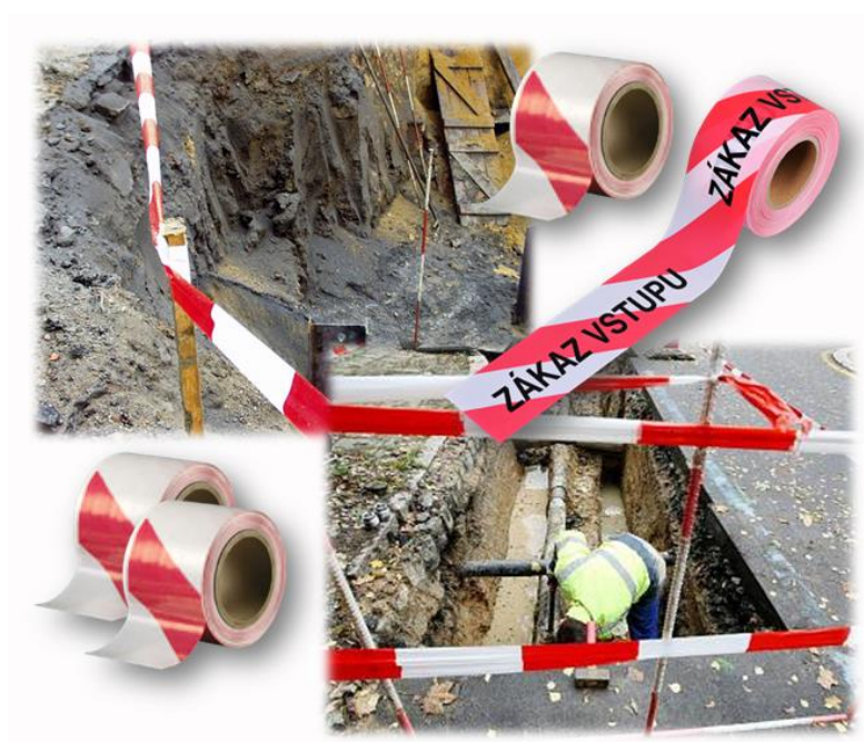
Obrázek 3.5.1 10 – Bariérová páska, zabezpečení jámy páskou na ocelových/dřevěných tyčích
