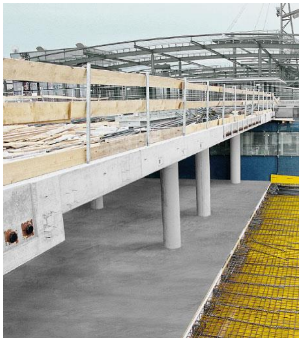
Obrázek 3.9.1 11 – Příklad konstrukce zábradlí
