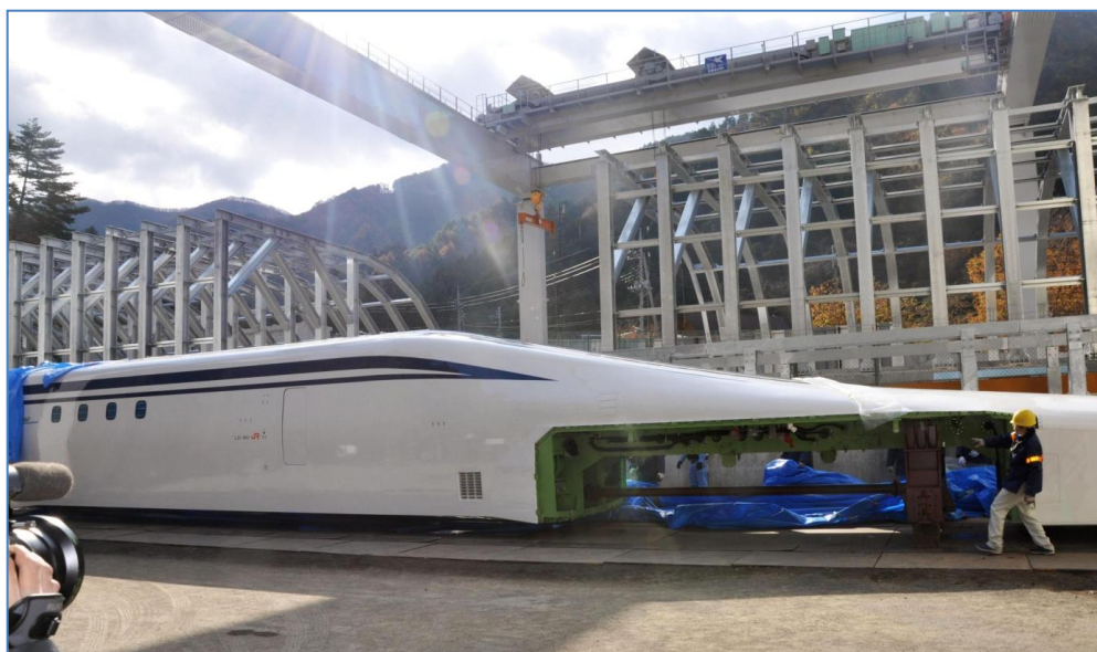
Obr. 9 Krajní vůz soupravy L0 bez instalovaného podvozku [13]
