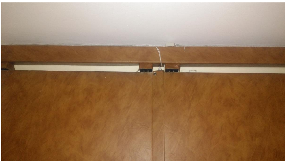
Obrázek 23 Instalovaný magnetický senzor
