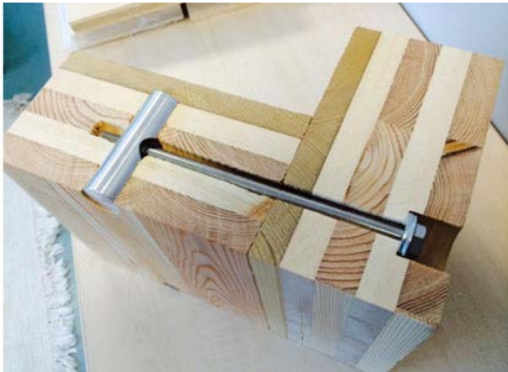
fig 20, Spojování CLT panelů
