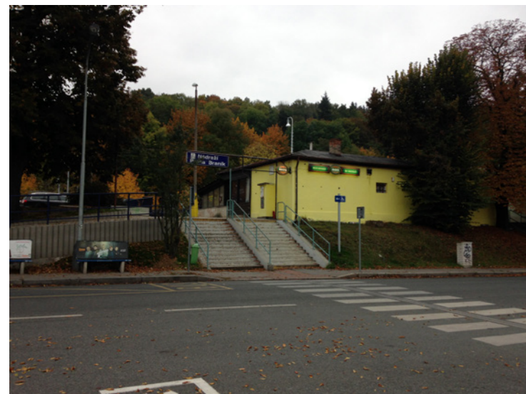
budova nádraží Braník
