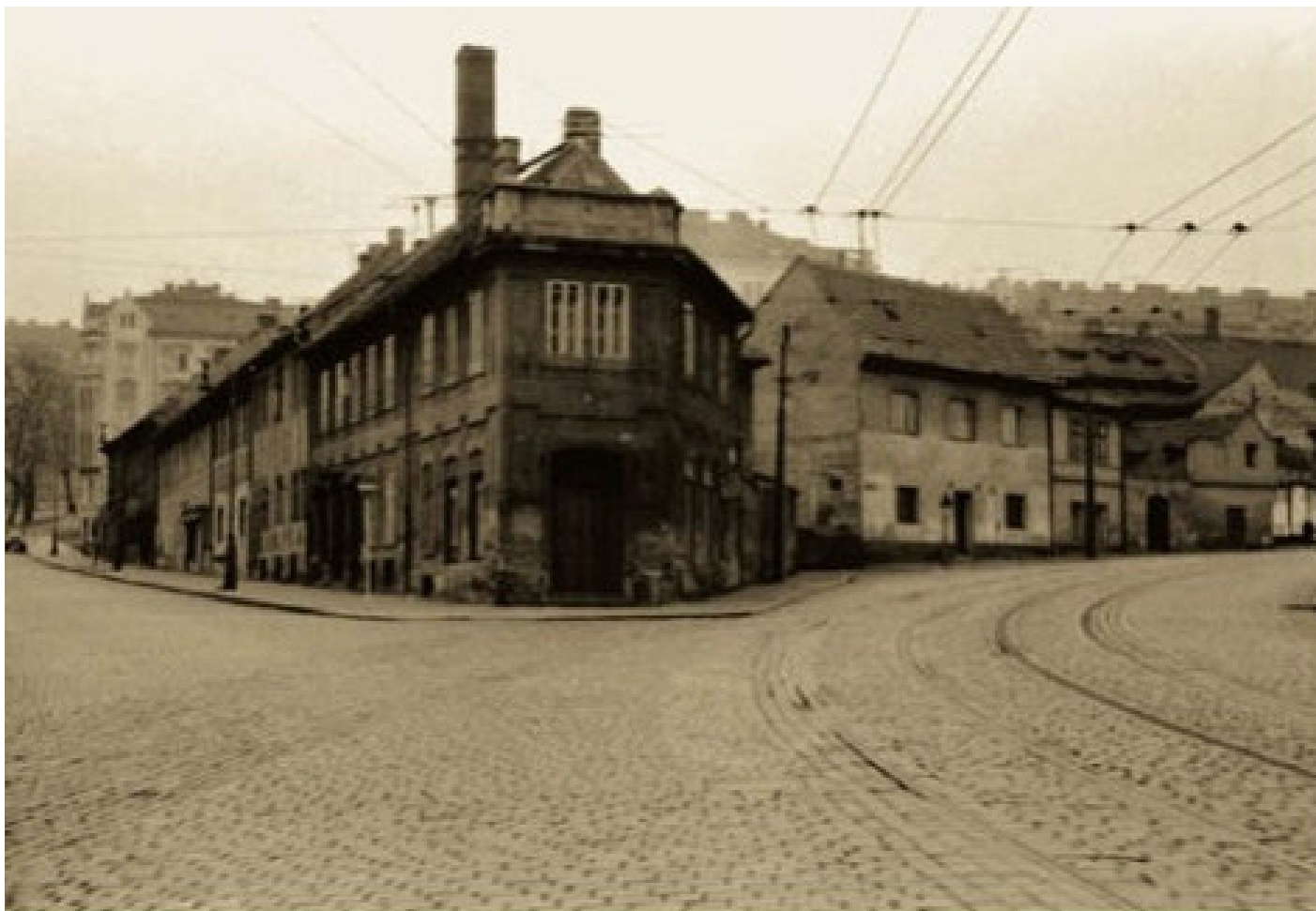
Snímek z ulice Primátorské vlevo a dnešní Zenklovy (dříve Fügnerovy) vpravo. V popředí Jungmannův dům, bývalé pekařství, byl zbořen na přelomu r. 1964–65. Ostatní objekty byly odstraněny v souvislosti s výstavbou tzv. holešovické přeložky v 1. pol. 70. let 20. století. (foto asi z 60. let 20. století)
