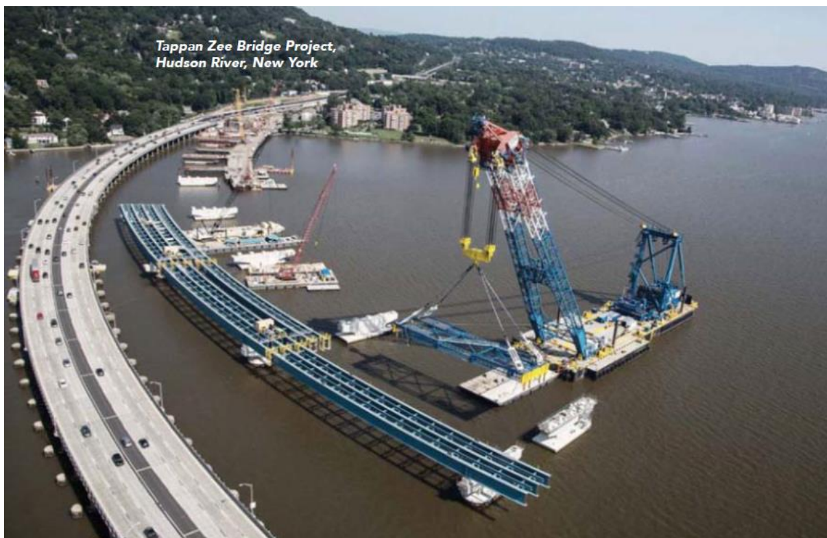
Obrázek 10 Výstavba nového mostu Tappan Zee, největší projekt mostu v USA, zdroj: Fluor, 2016
