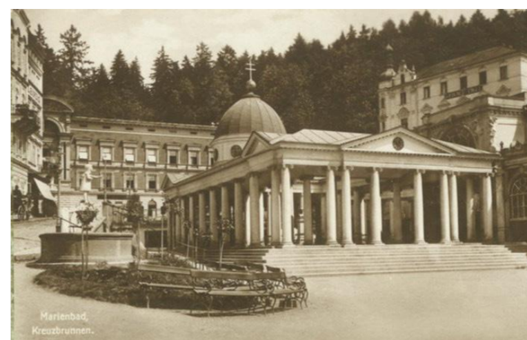
Pavilon Křížového pramene a pohled na Hlavní třídu
