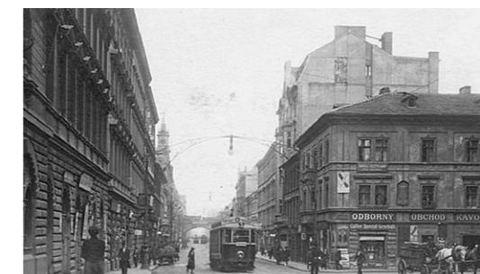
Zavedenie elektrickej tramvaje v ulici Sokolovská.
