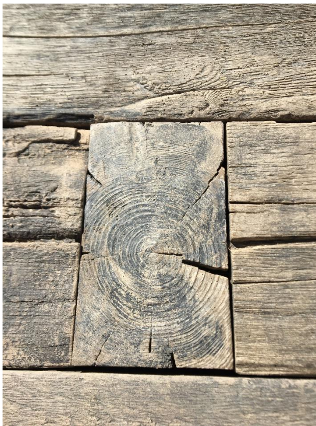
Obrázek 1 - Otisk pláště bednění - hrubé dřevo [Autor: Tereza Křížánková]
