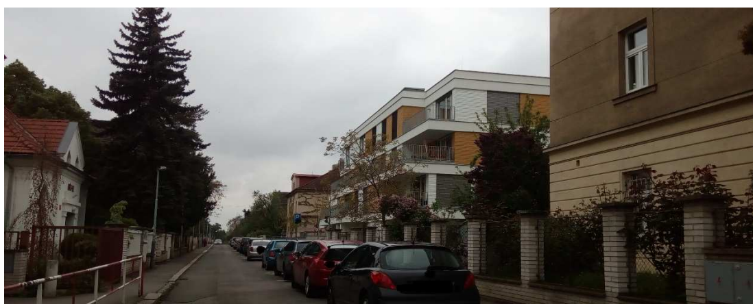
Obr. 10, 11 – Dokončený bytový objekt Vilová
