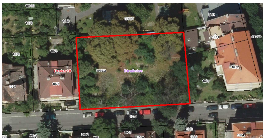
Obr. 9 - Letecký snímek pozemku staveniště (9)
