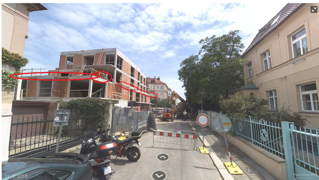
Obr. 21 – Chybí okopové prkno (9)
