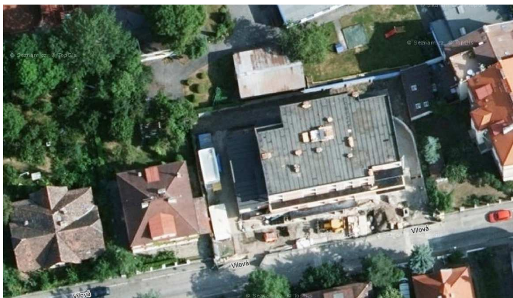
Obr. 23 – Realizace střechy na objektu Vilová (9)
