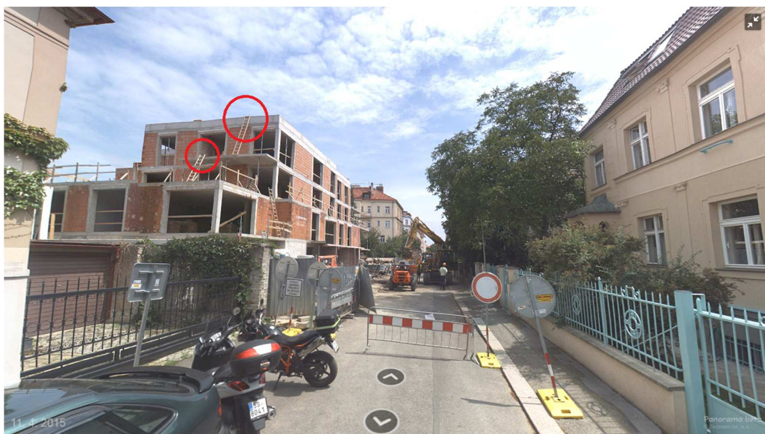
Obr 19 – Žebřík nepřesahuje nástupní plošinu o 1,1 m (9)
