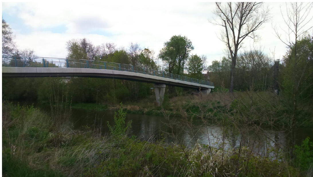
Fotografie 8 - Fotodokumentace stávajícího stavu - pohled z Božkova
