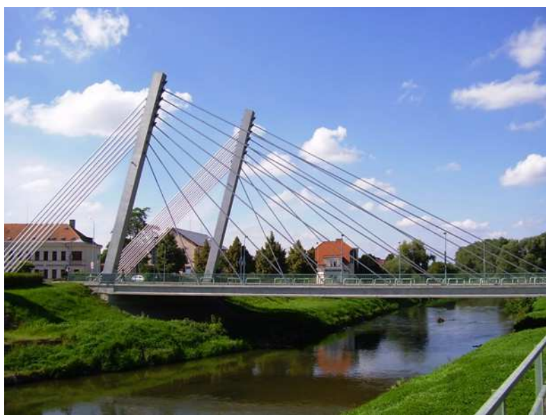
Fotografie 5 - Most přes Svratku v Židlochovicích
