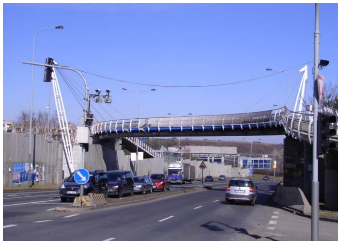
Fotografie 6 - Lávka Barrandov
