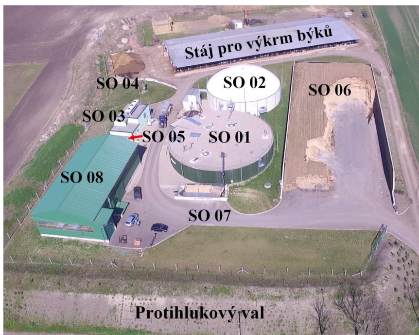
Obr. 2: Fotografie s vyznačením jednotlivých stavebních objektů
