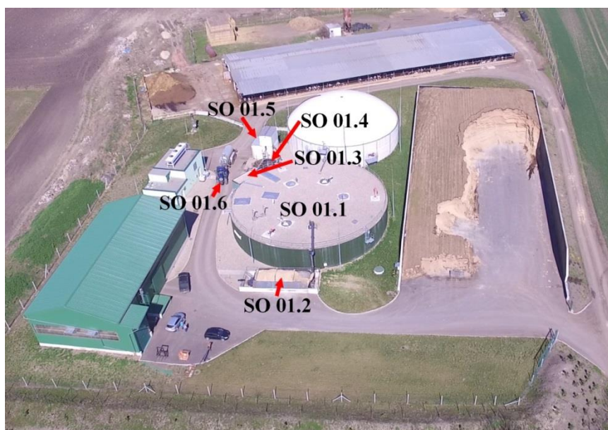
Obr. 3: Fotografie umístění fermentoru a obslužných objektů
