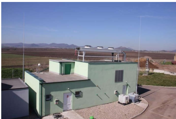
Obr. 11: Fotografie budovy kogenerace a velínu
