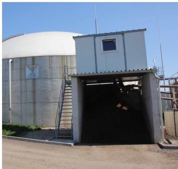
Obr. 8: Fotografie objektu separátoru
