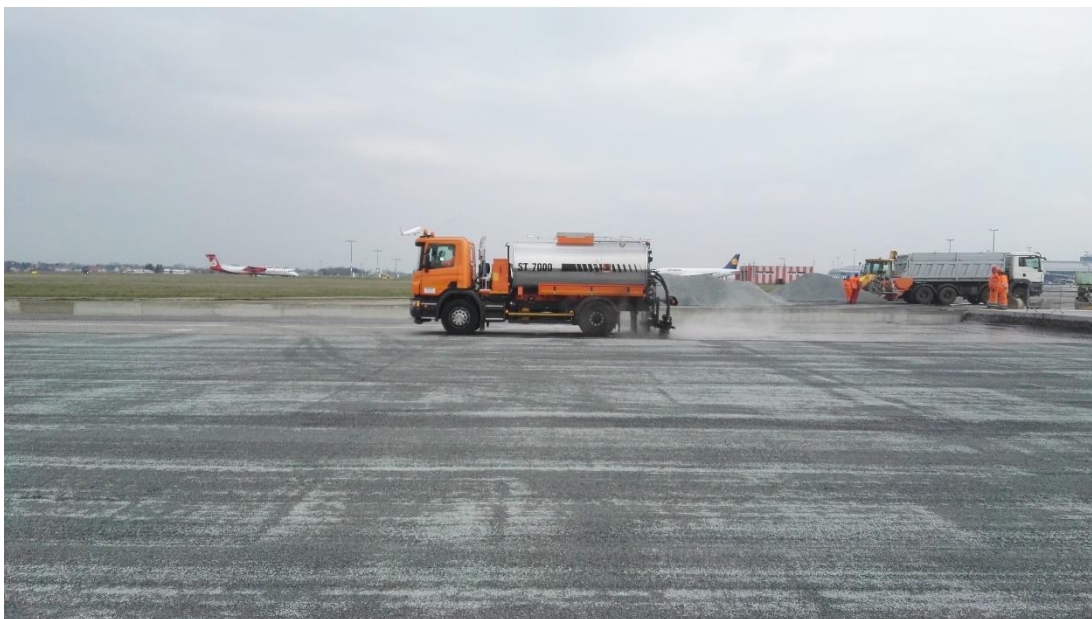
Obr. 8 - Vůz s cisternou na asfaltové směsi [Archiv autora]
