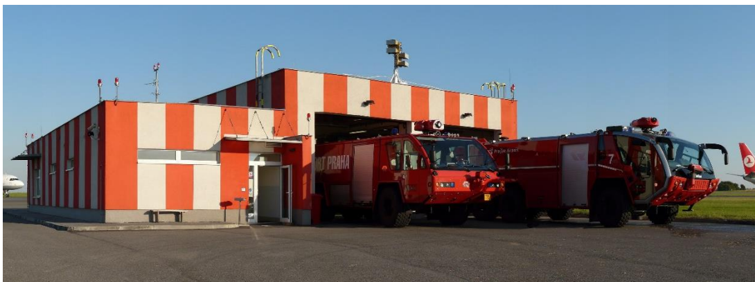
Obr. 4 - Hasičská stanice na letištní ploše [7]
