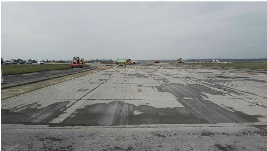
Obr. 10 - Dokončená fáze frézování původního povrchu [Archiv autora]
