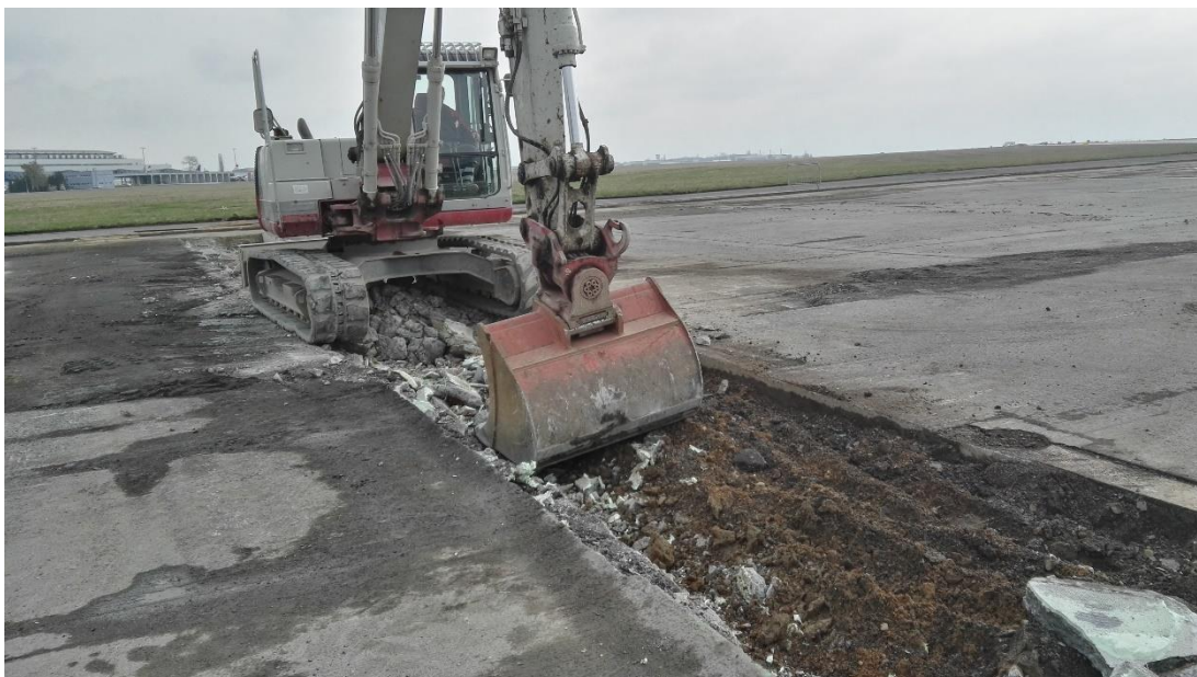
Obr. 12 - Provádění výkopu pro odvodňovací kanál [Archiv autora]
