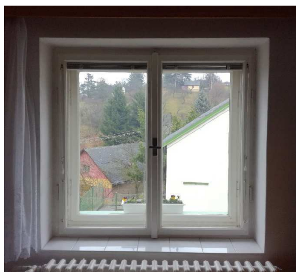
obr.2-pohled na měřené okno
