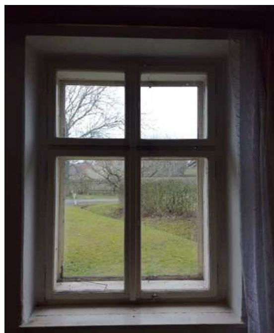
obr.2- pohled na měřené okno
