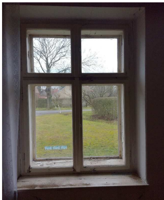
obr.2- pohled na měřené okno
