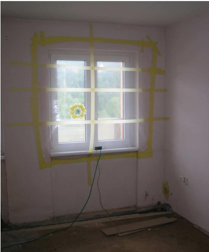
Pohled na okno s nalepenou fólií a osazenou měřicí clonou (foto poskytnul Jiří Novák)
