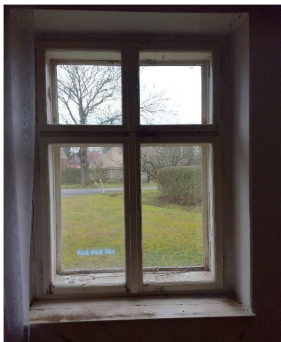
obr.2- pohled na měřené okno
