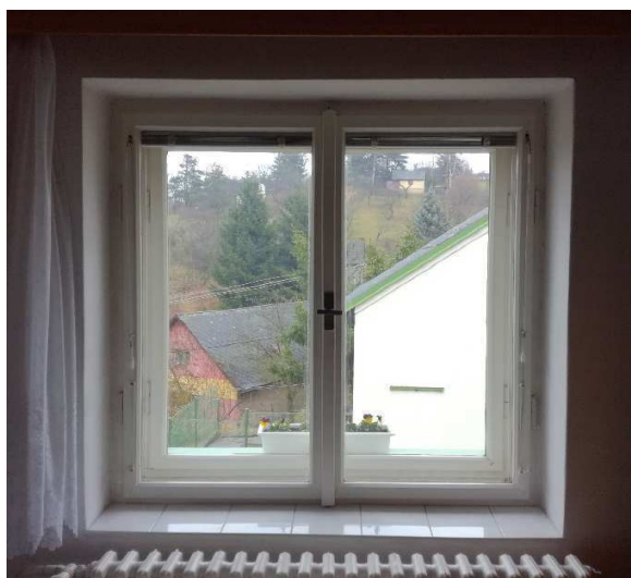
obr.2-pohled na měřené okno
