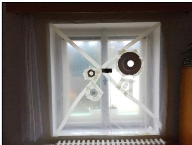
Obr. č.22: Pohled na okno s nalepenou fólií a osazenou clonou
