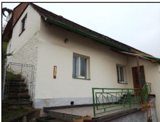
Obr. č.19: Pohled na měřené okno (uprostřed obrázku)
