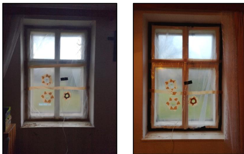
Obr. č.17: Pohled na okna s nalepenou fólií a osazenou clonou, vlevo – okno vlevo při pohledu z interiéru, vpravo – okno vpravo při pohledu z interiéru
