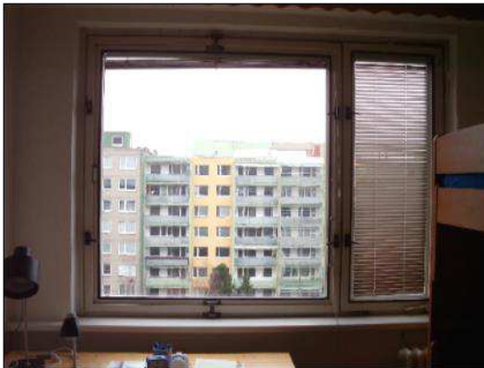
Obr.1: Pohled na okno [10]
