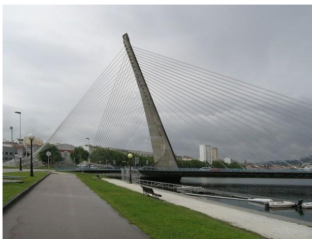
Obrázek 8: Lerez River Bridge – boční pohled [4]
