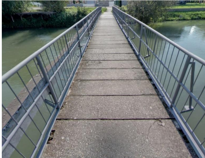
Obrázek 3: Pohled na mostovku a zábradlí stávající lávky [2]
