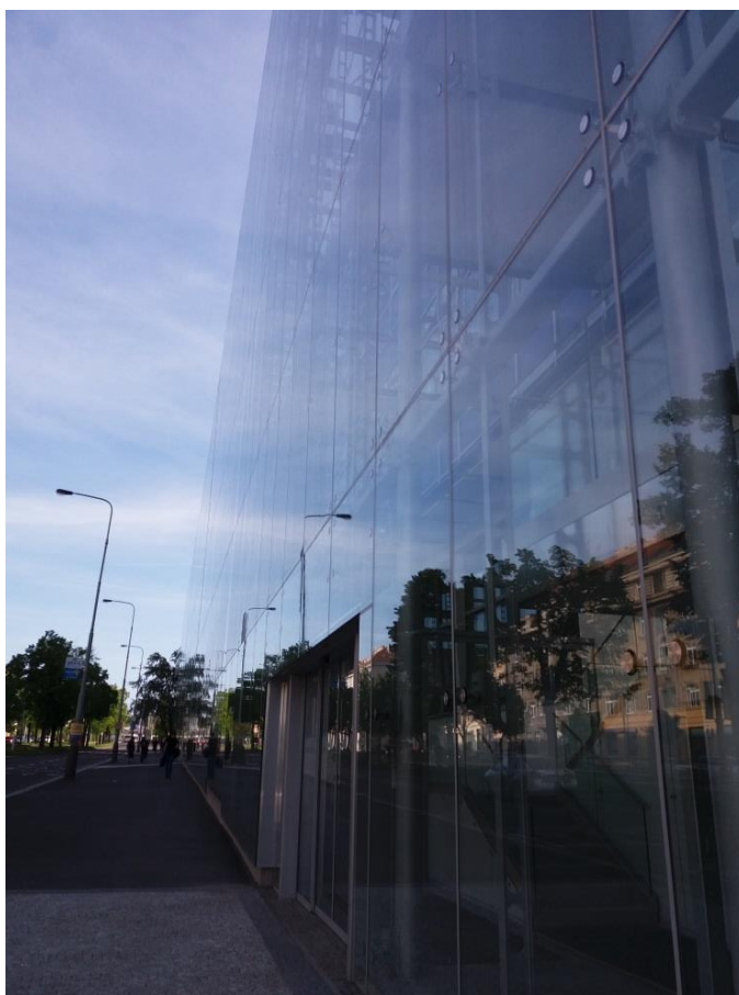
Obr. 30: Předsazená terčová fasáda [vlastní zdroj]
