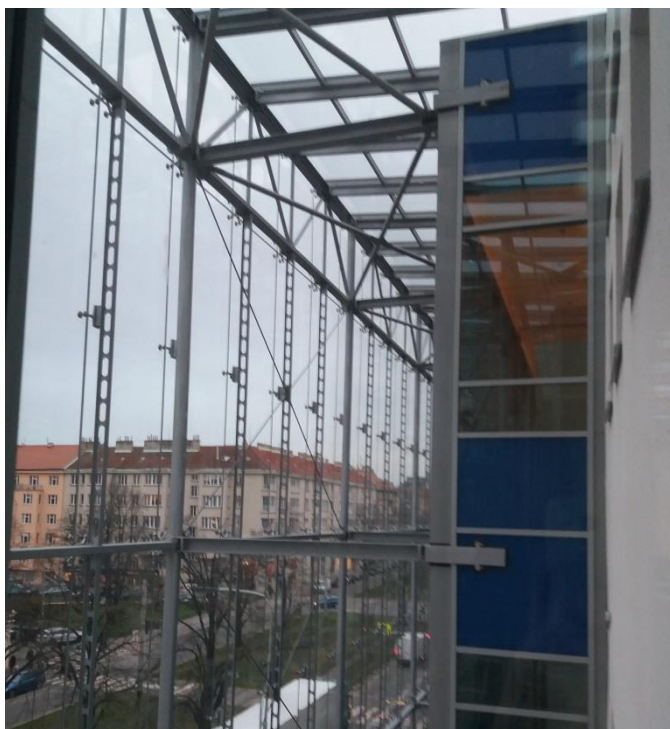
Obr. 33: Předsazená terčová fasáda zevnitř [vlastní zdroj]
