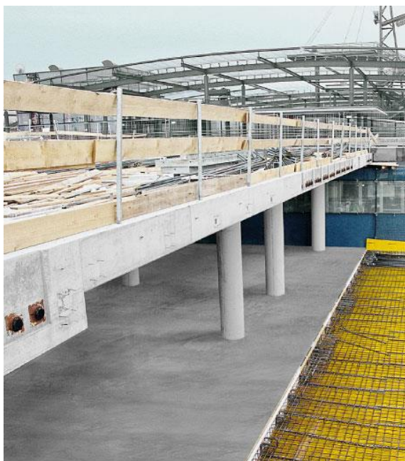
Obr. 14: Ochranné zábradlí včetně okopové zarážky [15]
