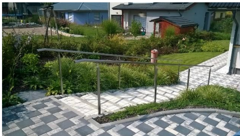
Obr. 16: Ochranné zábradlí jednotyčové bez výplně [16]
