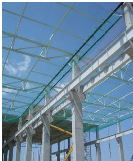
Obr. 17: Bezpečnostní síť typu S [17]
