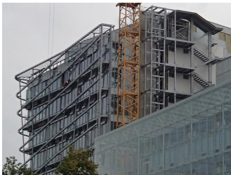
Obr. 28: ETFE fasáda při realizaci [zdroj: Pavel Svoboda]
