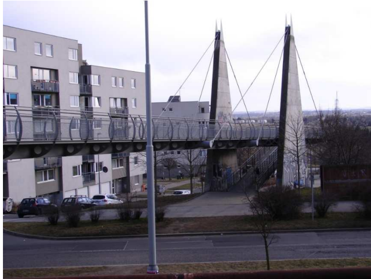
Foto 26 - Lávka přes Ocelkovu ulici, pohled ze severního svahu
