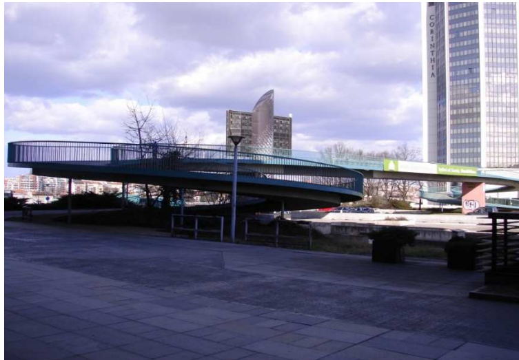
Foto 21 - Lávka u Nuselského mostu, pohled na rampu
