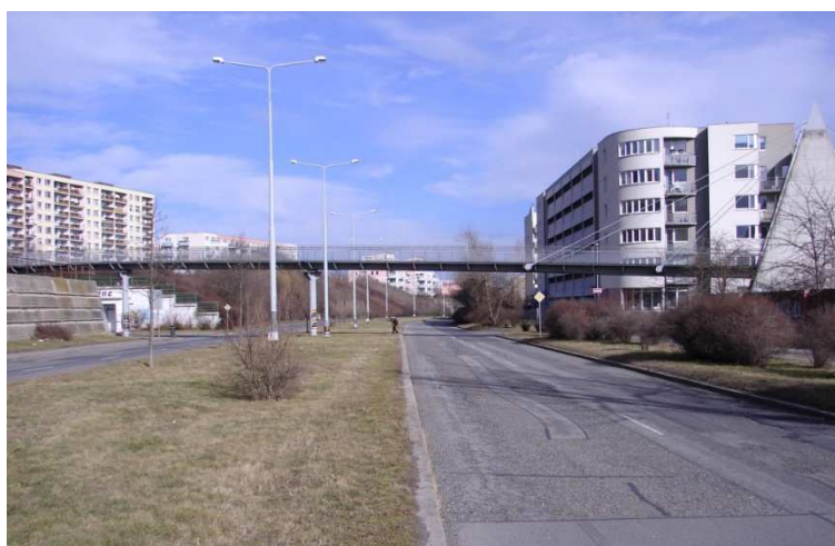
Foto 25 - Lávka přes Ocelkovu ulici, pohled z Ocelkovi ulice
