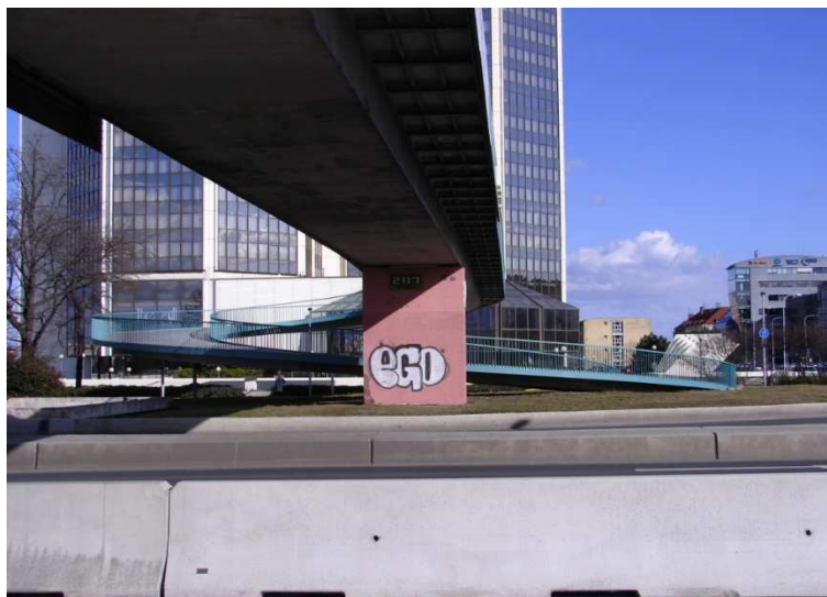
Foto 22 - Lávka u Nuselského mostu, pohled na konstrukci
