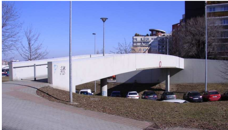
Foto 6 - Lávka přes Wassermannovu ulici, pohled z Pražské čtvrti
