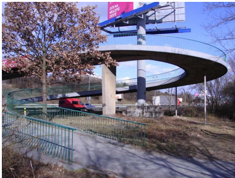
Foto 20 - Lávka na Spořilově, pohled na rampu
