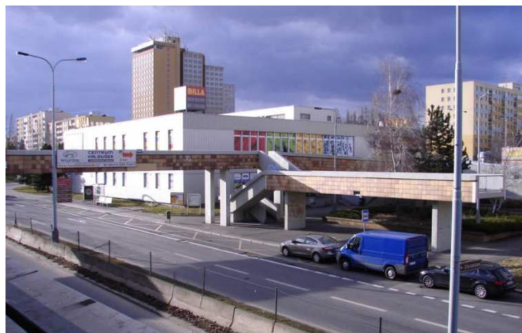
Foto 11 - Ke Kateřinkám, pohled z víceúčelového domu
