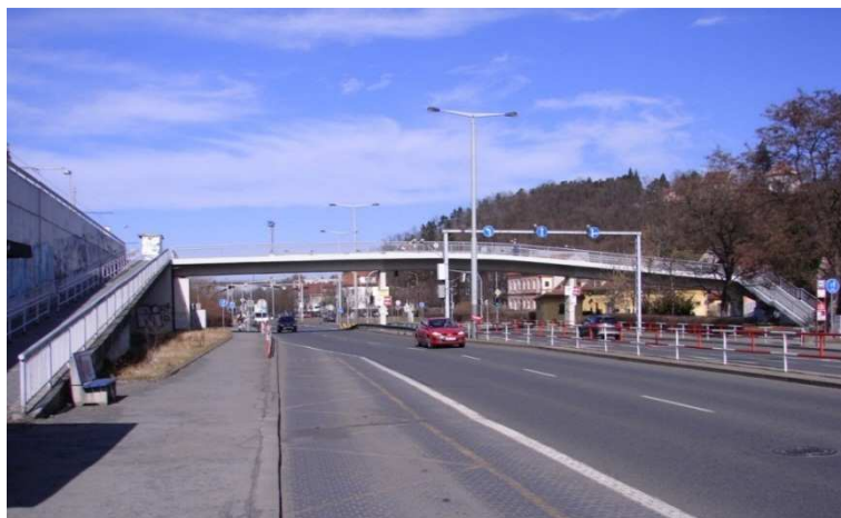
Foto 9 - Lávka přes Modřanskou ulici, pohled z Modřanské
