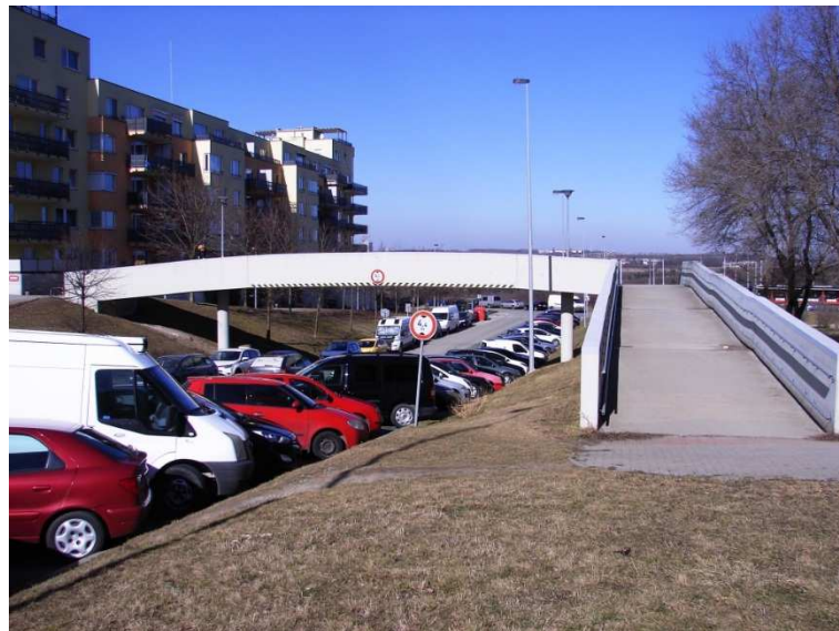
Foto 5 - Lávka přes Wassermannovu ulici, pohled z Wassermannovi ulice
