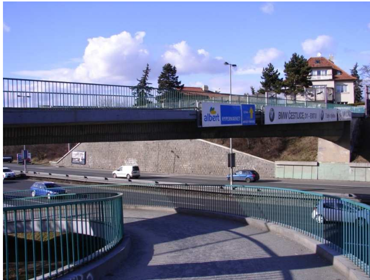
Foto 19 - Lávka na Spořilově, pohled na přemostění
