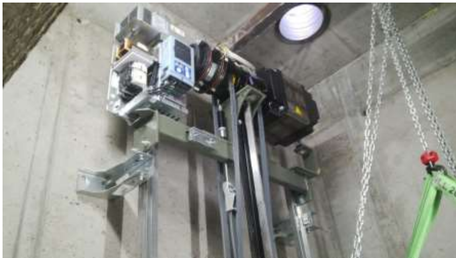
Obr. 11: Umístění výtahového stroje
