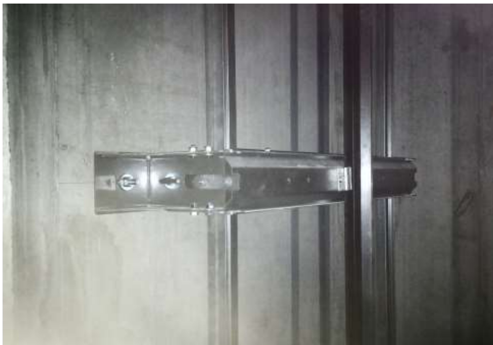
Obr. 10: Kotvení hlavních vodiček a vodiček závaží
