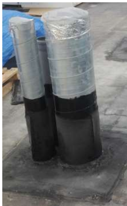
Obr.4: Vyústění potrubí na střeše
