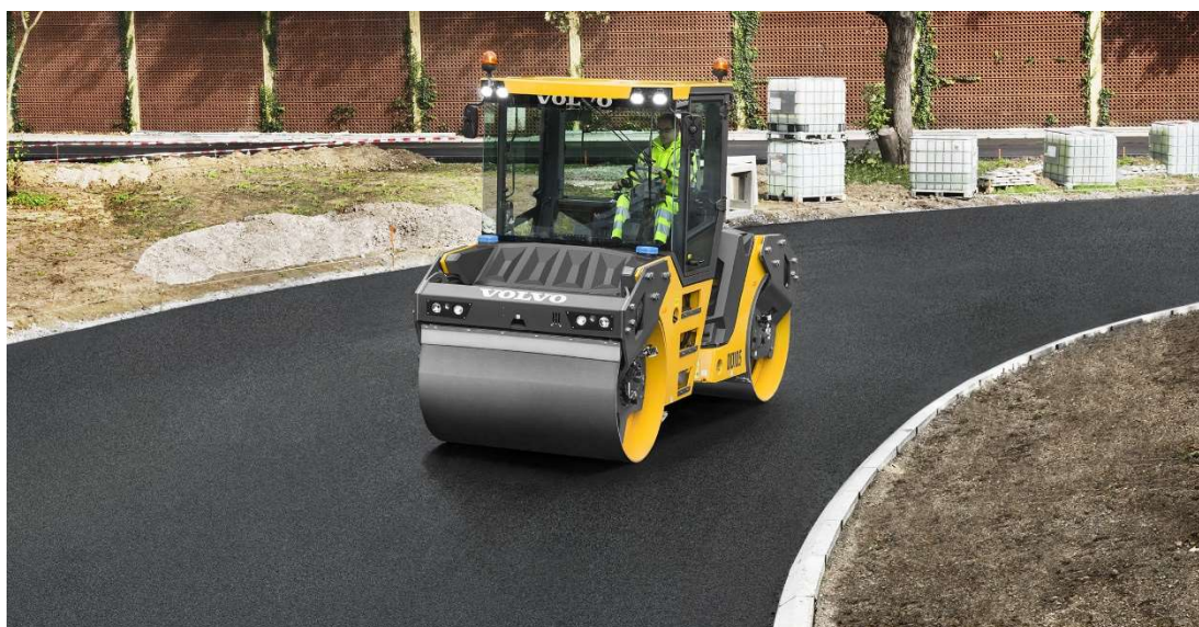
Obr. 16: Asfaltový finišer Volvo DD105
