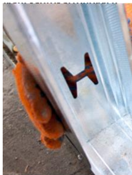
Obr. 19: Výsek v CW profilu (H-prolis)
