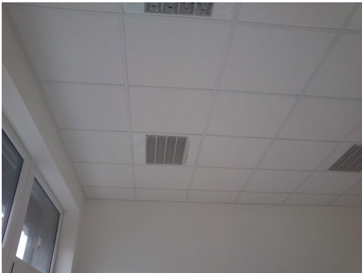
Obr. 44: Dokončené sádrokartonové konstrukce před předáním
