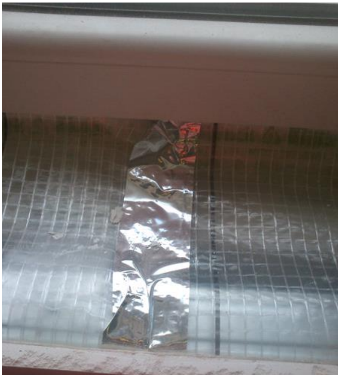
Obr. 34: Spoj parozábran předstěny obvodové nosné zdi
