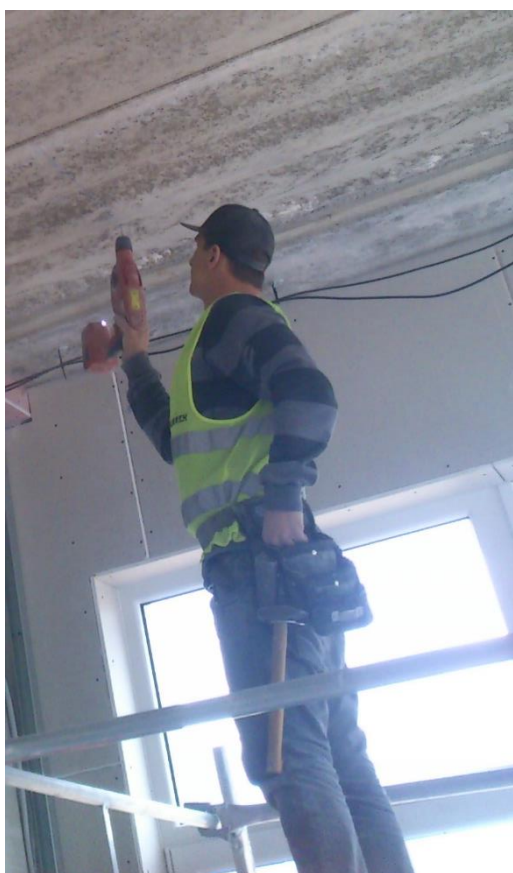
Obr. 23: Vrtání otvoru pro hmoždinku
