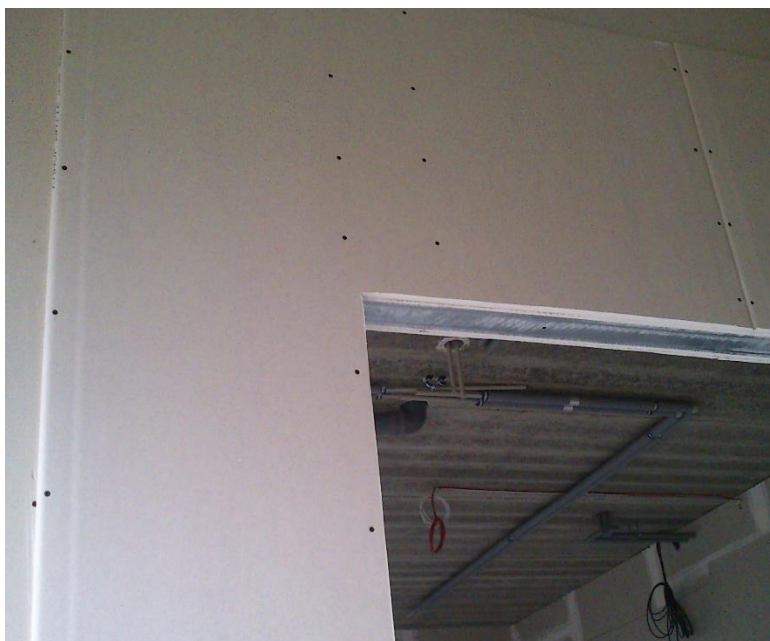
Obr. 40: Správně opracovaná a připevňovaná deska v místě rohu otvoru
