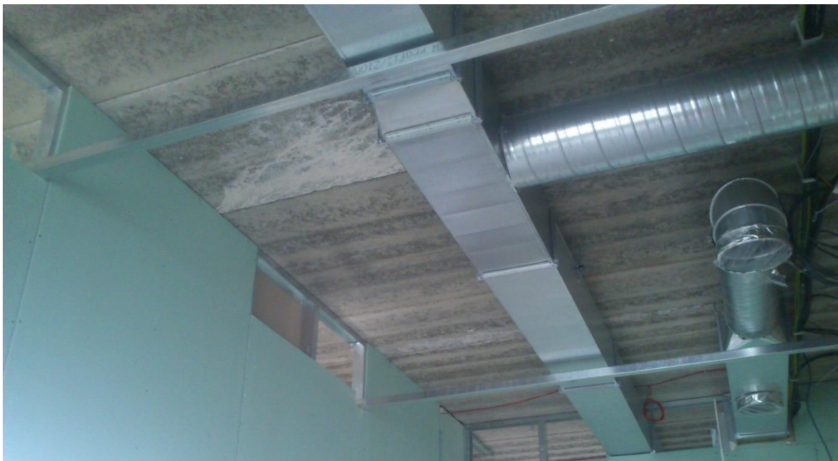
Obr. 28: Profily CW 50 ukotvené do polopříčky
