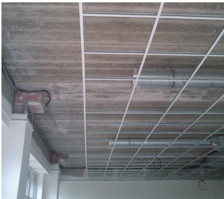
Obr. 42: V zadní části místnosti zřetelná křivost linie rastru
