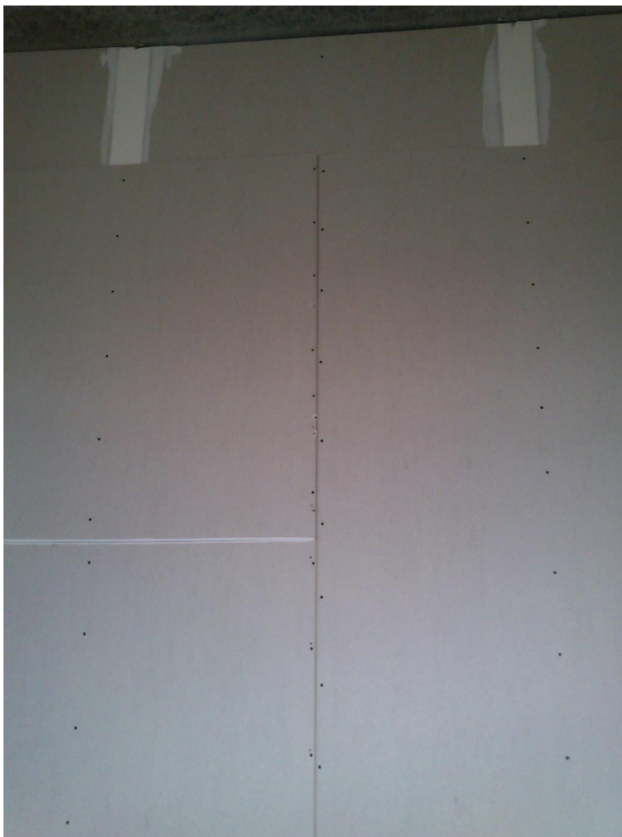
Obr. 36: Znázornění správného prostřídání desek 1. a 2. vrstvy opláštění
