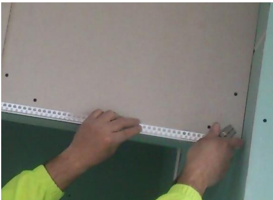
Obr. 21: Upevňování rohové ALU lišty na hranu SDK desek
