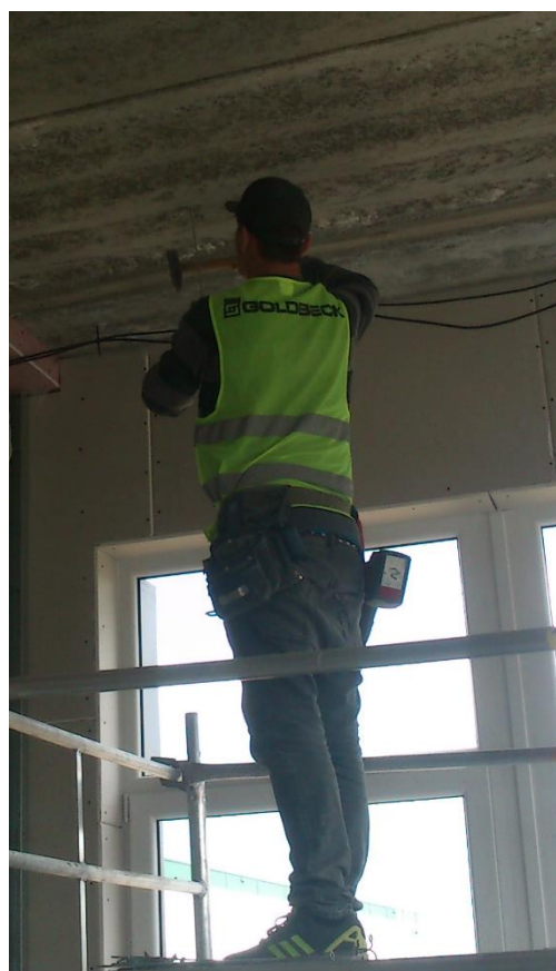
Obr. 24: Natloukání hmoždinky
