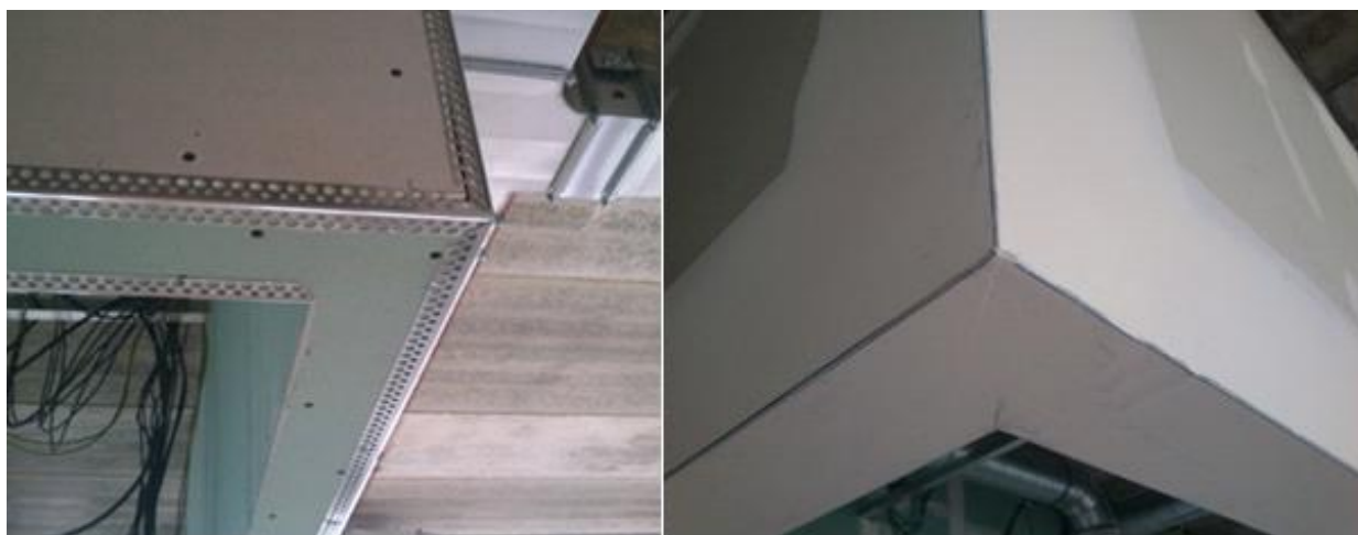
Obr. 38: a) připevněné profily, b) stejné místo po zatmelení
