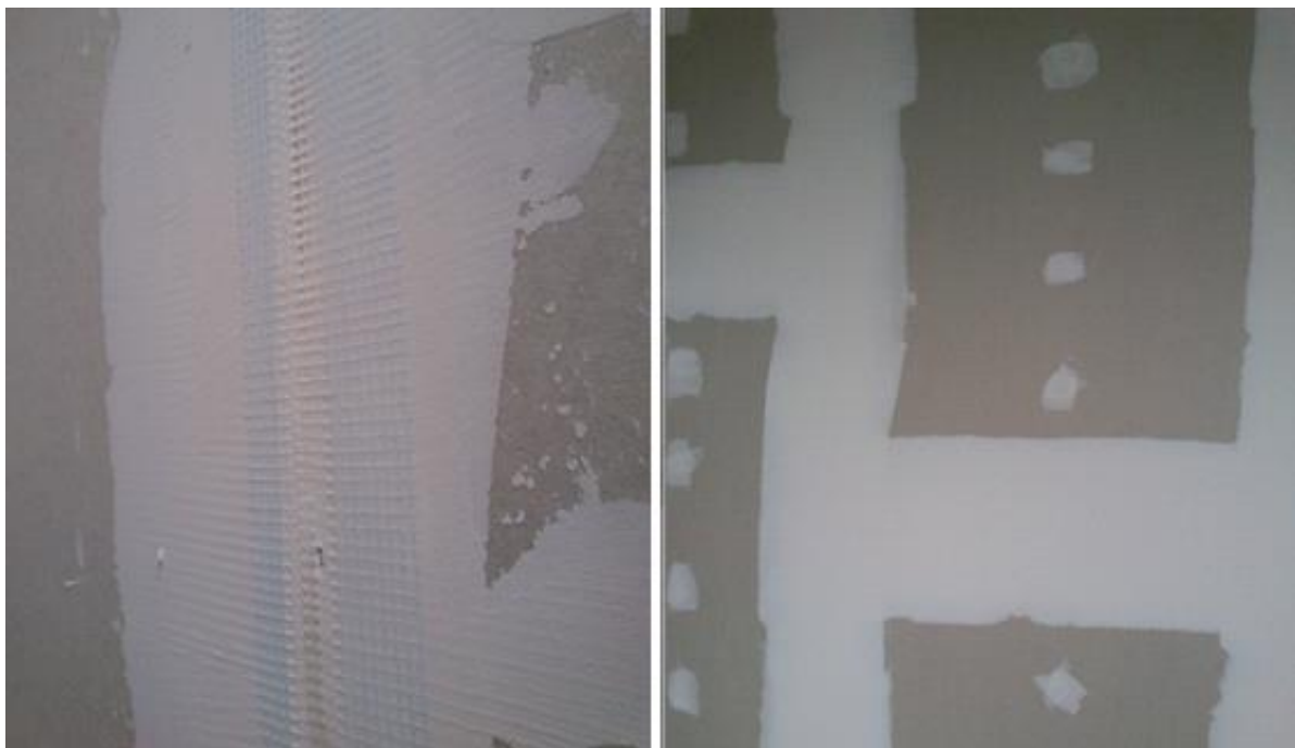
Obr. 39: a) výztužná páska zahlazená do stěrky, b) přetmelené spáry a hlavičky šroubů finálním tmelem
