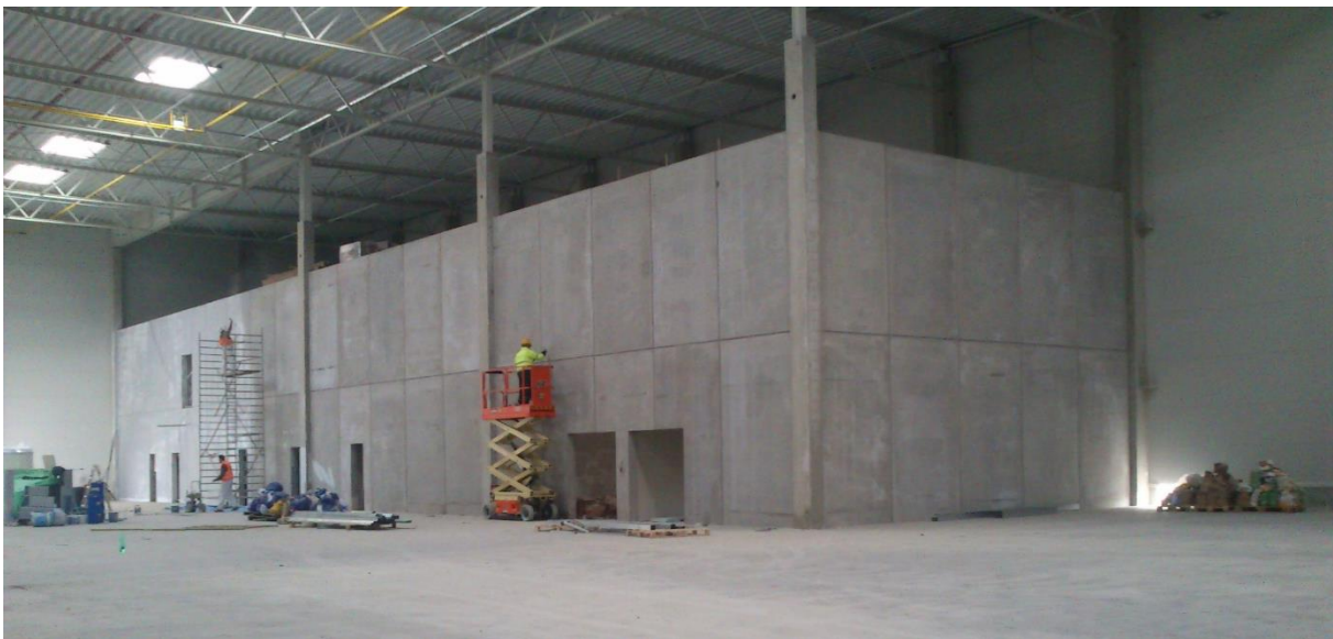
Obr. 16: Vestavek ve skladové hale, v kterém probíhala realizace sádrokartonových konstrukcí
