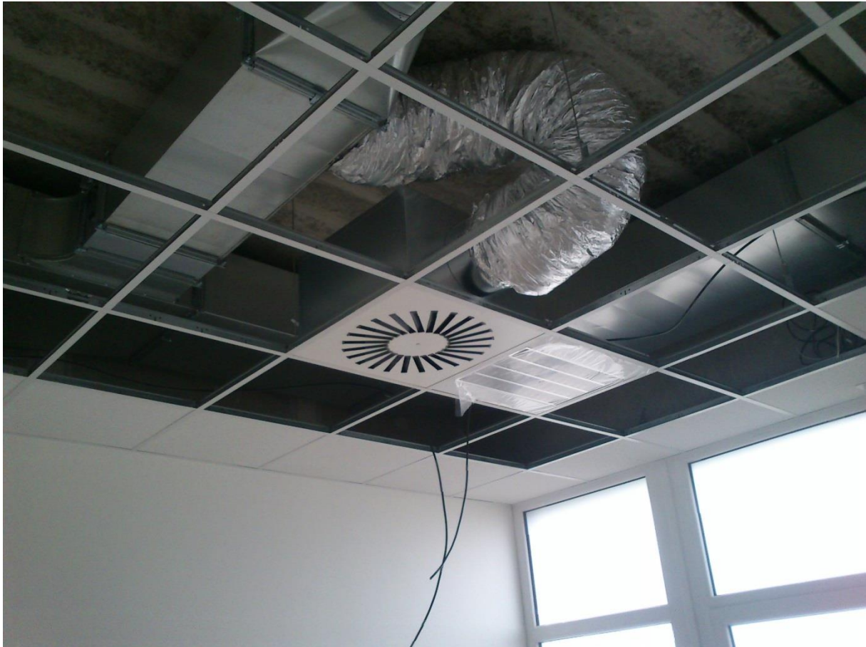
Obr. 43: Zabudované příslušenství (vzduchotechnika a světlo) před zaklopením podhledovými deskami
