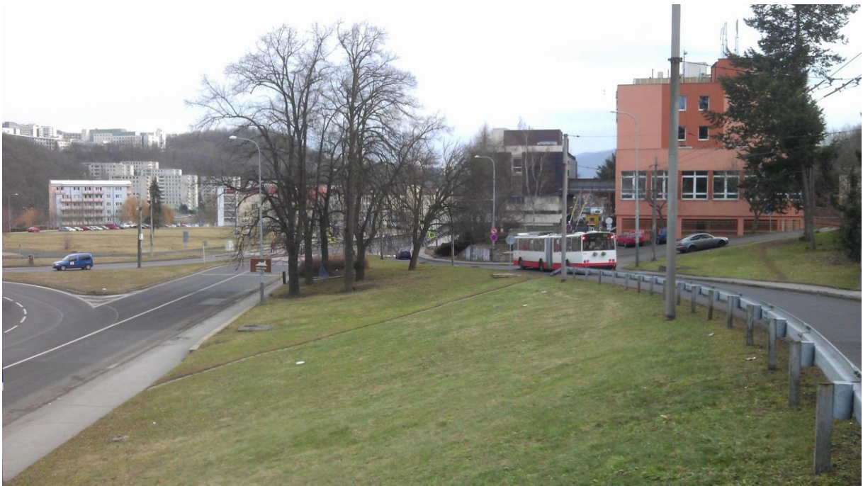
Obr. 6: Nadjezd přes ulici Všebořická
