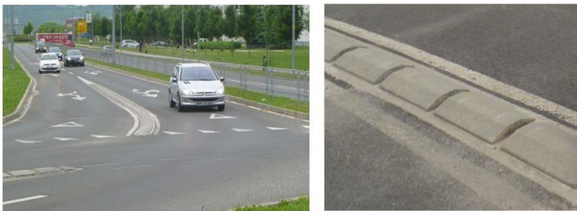
Obr. 21 Fyzické oddělení jízdních pruhů (vlevo) s odvodňovací spárou (vpravo)
