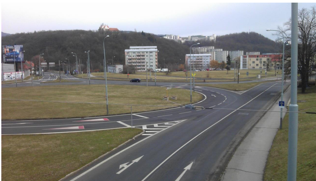
Obr. 12: Tangenciální napojení hlavní komunikace v ul. Všebořická na okružní pás
