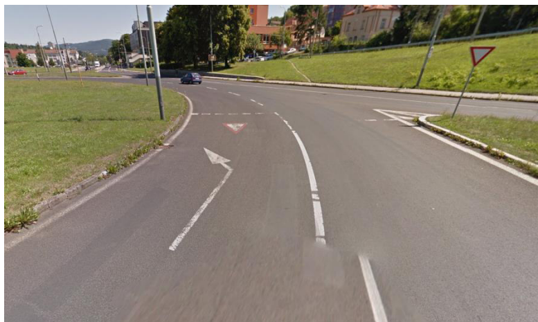
Obr.10: Nedostatečně výrazná V6a na vnějším okružním jízdním pásu ( www.google.cz )
