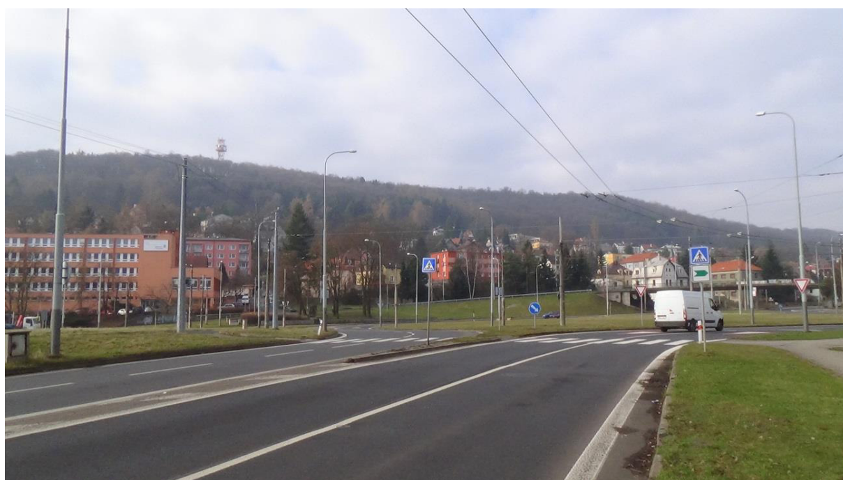
Obr. 4: Ulice Božtěšická, vjezdová větev - odvodnění v nevyhovujícím stavu
