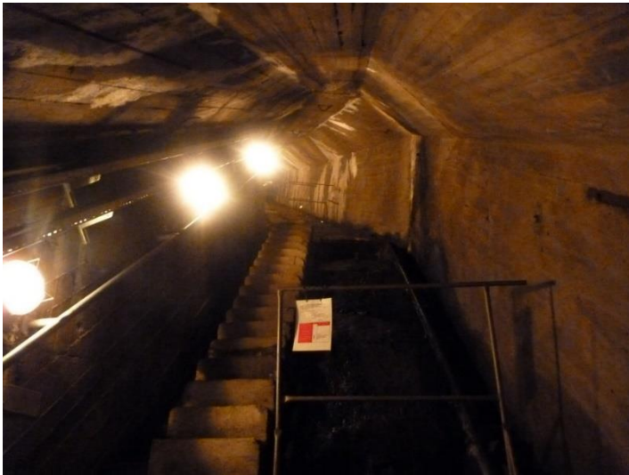
Obrázek 3: Injekční chodba (foto autor 10.4.2017)
