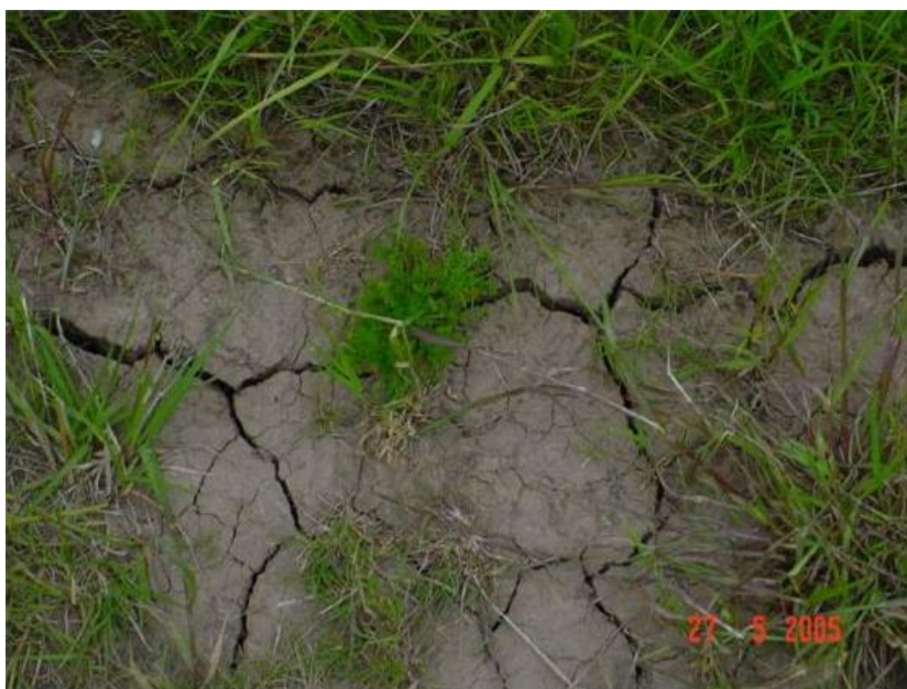
Obrázek 10: Trhliny od vysychání na koruně nové hráze [15]
