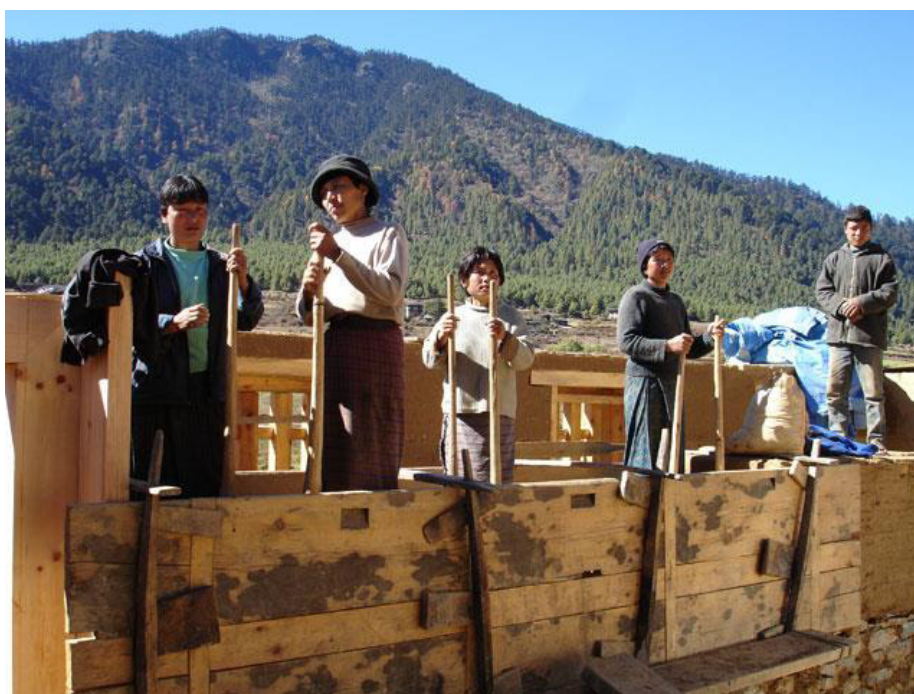
Obrázek 27 - Posuvné dřevěné bednění tzv. sáňky
