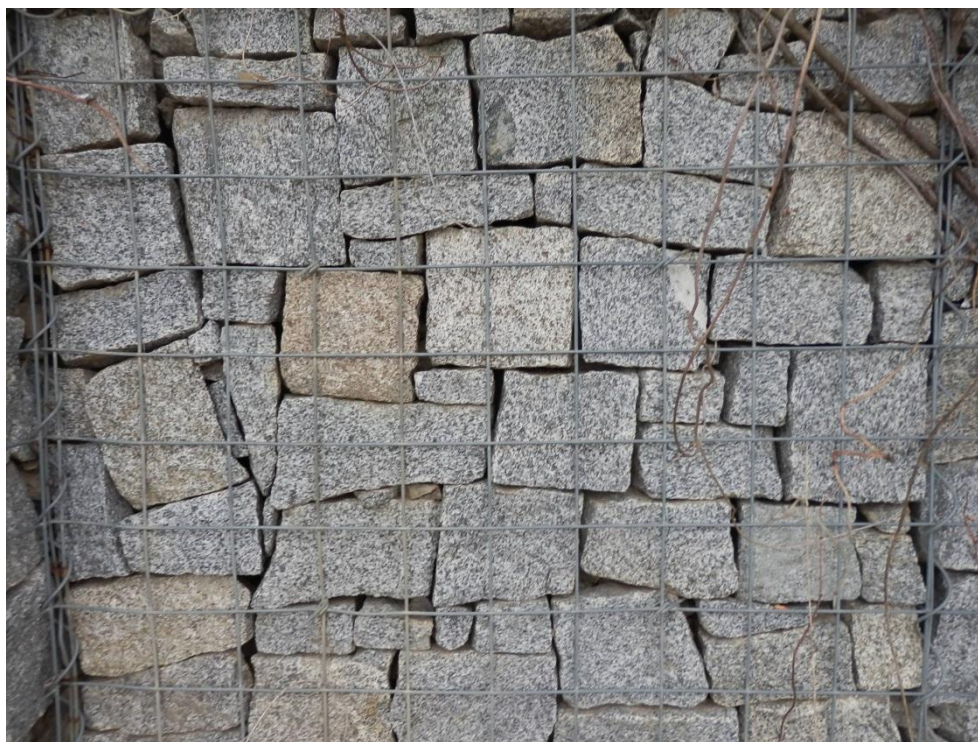
Obr. 21 Detail gabionové PHS – Průhonice [autor]
