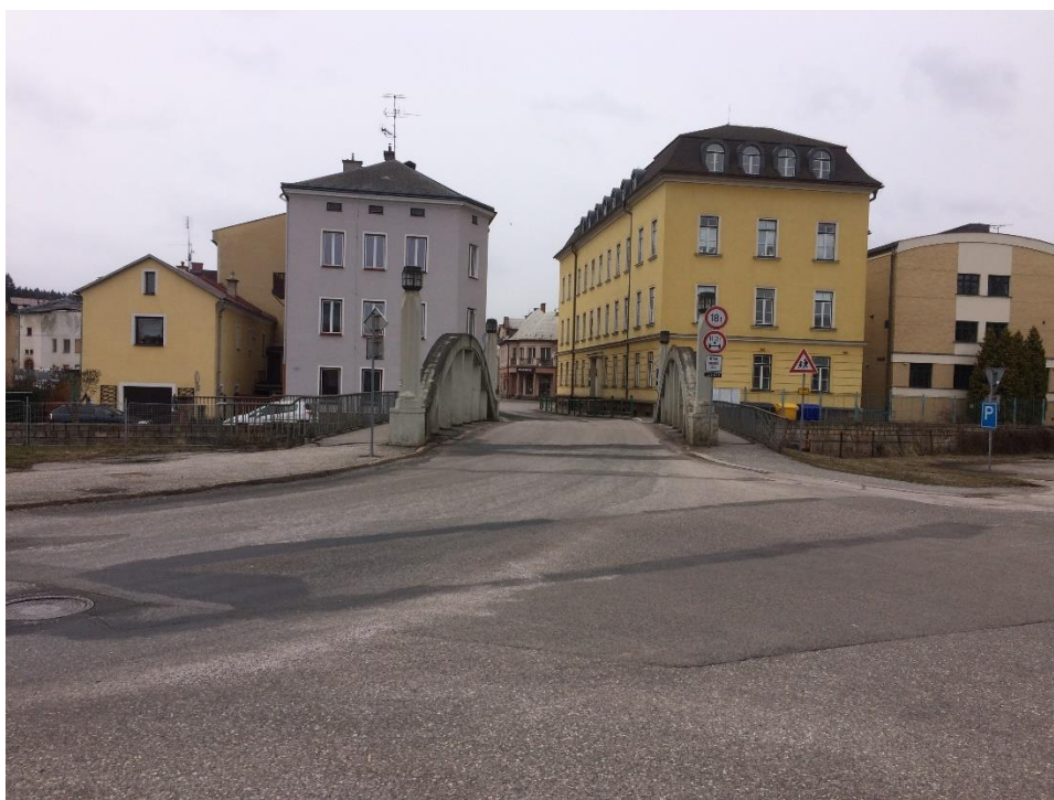
Obrázek 13 - Prostor křižovatky a historického mostu z roku 1926
