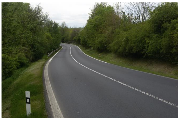
Obrázek 34: Směrové oblouky č. 10 (bližší) a č. 8 (vzdálenější) foceno proti směru staničení
