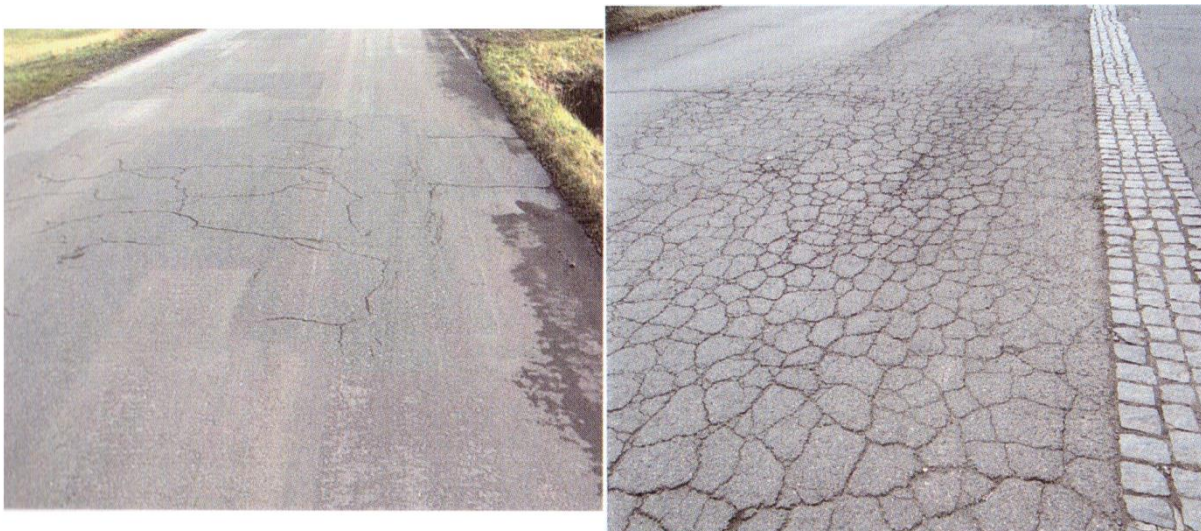
Obrázek 5: Mozaikové trhliny (vlevo) a síťové trhliny (vpravo)
