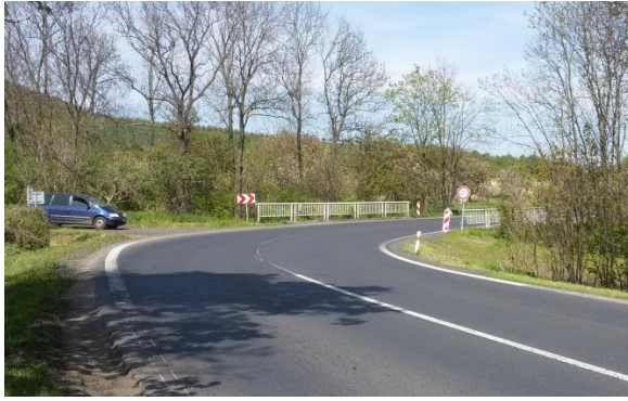
Obrázek 35: Směrový oblouk č. 12 focen po směru staničení
