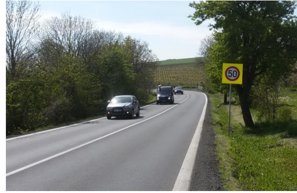
Obrázek 36: Směrový oblouk č. 12 focen proti směru staničení
