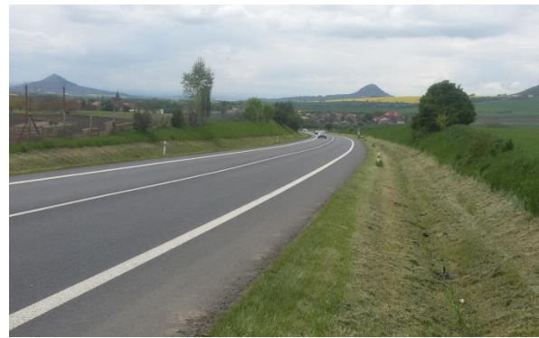
Obrázek 26: Směrový oblouk č. 4 focen proti směru staničení
