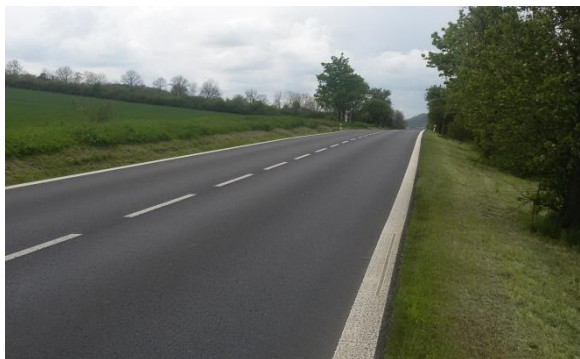
Obrázek 27: Přímý úsek č. 5 focen proti směru staničení
