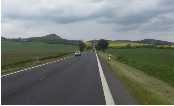
Obrázek 23: Přímý úsek č. 1 focen proti směru staničení
