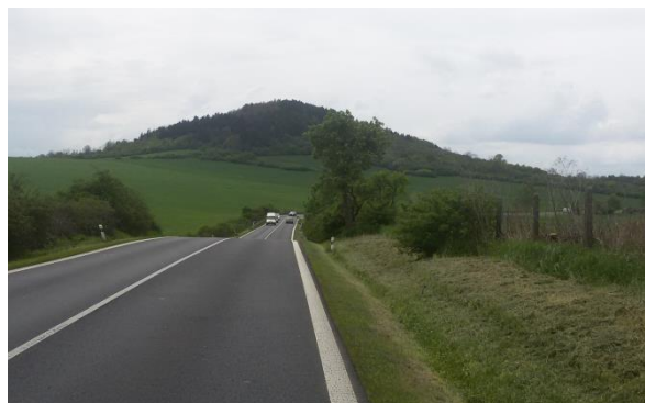
Obrázek 32: Pohled na řešený úsek ve směru proti staničení, přímý úsek č. 7
