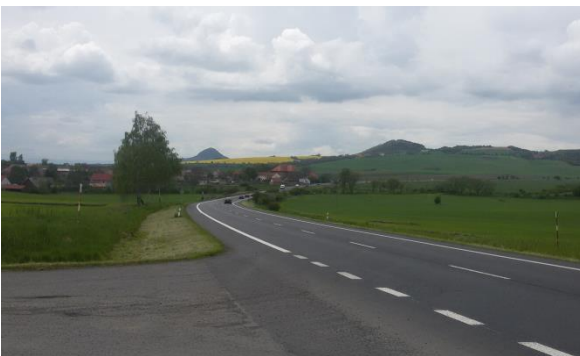
Obrázek 25: Směrový oblouk č. 2 focen proti směru staničení
