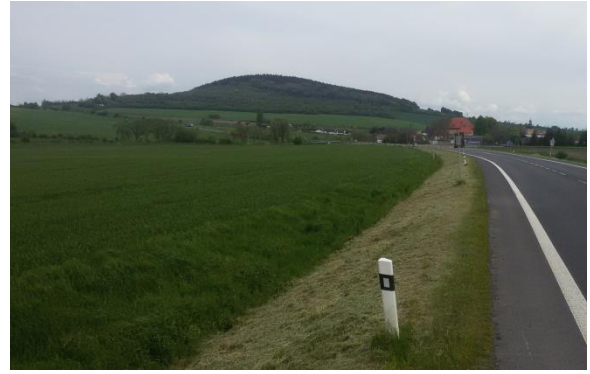
Obrázek 24: Směrový oblouk č. 2 focen po směru staničení
