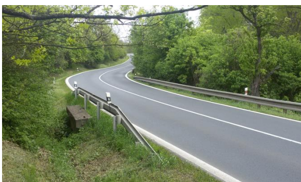
Obrázek 33: Směrové oblouky č. 8 (bližší) a č. 10 (vzdálenější) foceno po směru staničení
