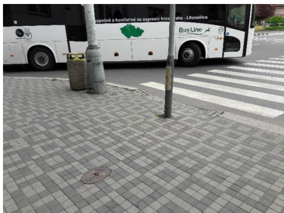
Obrázek 34: Příklad přechodu pro chodce, souč. stav ul. Osadní
