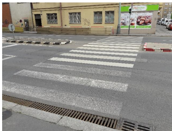
Obrázek 35: Příklad přechodu pro chodce, souč. stav ul. Vrbenského
