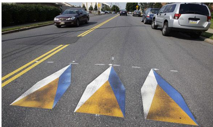
Obr. 23 Optický zpomalovací příčný práh (zdroj. http://autoplanet.cz )
