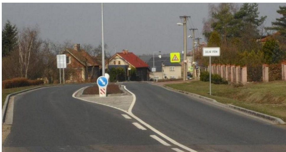
Obr. 40 Zúžení vozovky při vjezdu do obce (zdroj. http://m.hkregion.cz )
