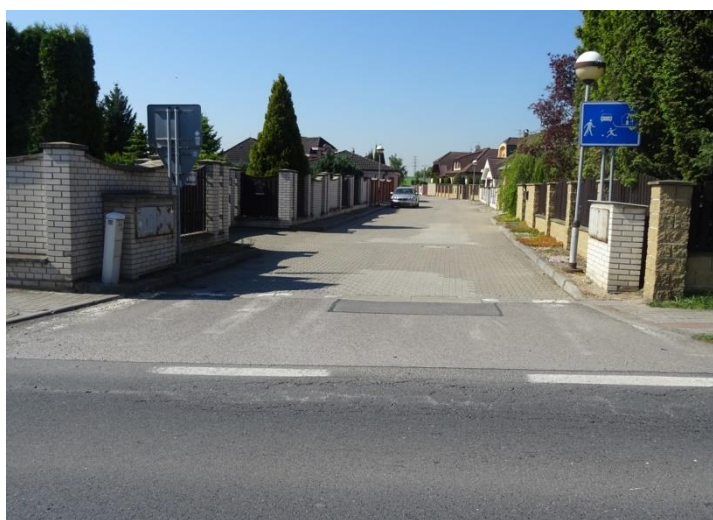
Obr. 25 Odlišný kryt vozovky při vjezdu o obytné zóny
