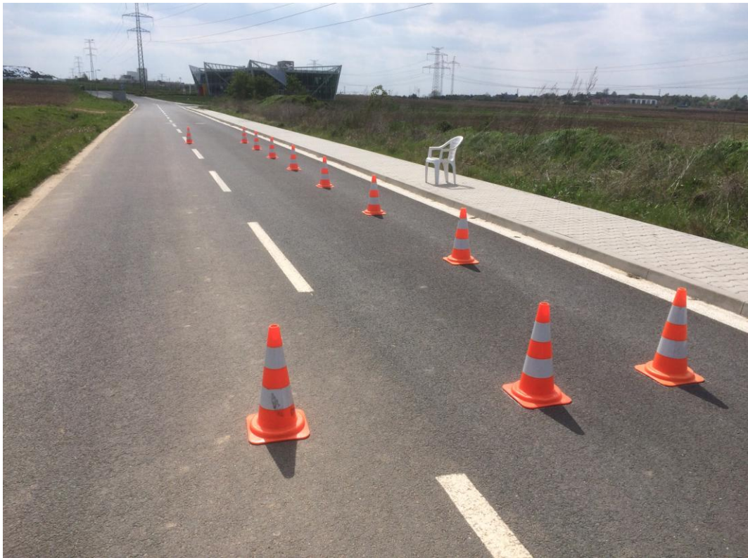
Obrázek 39 - Fotografie zkušební trati
