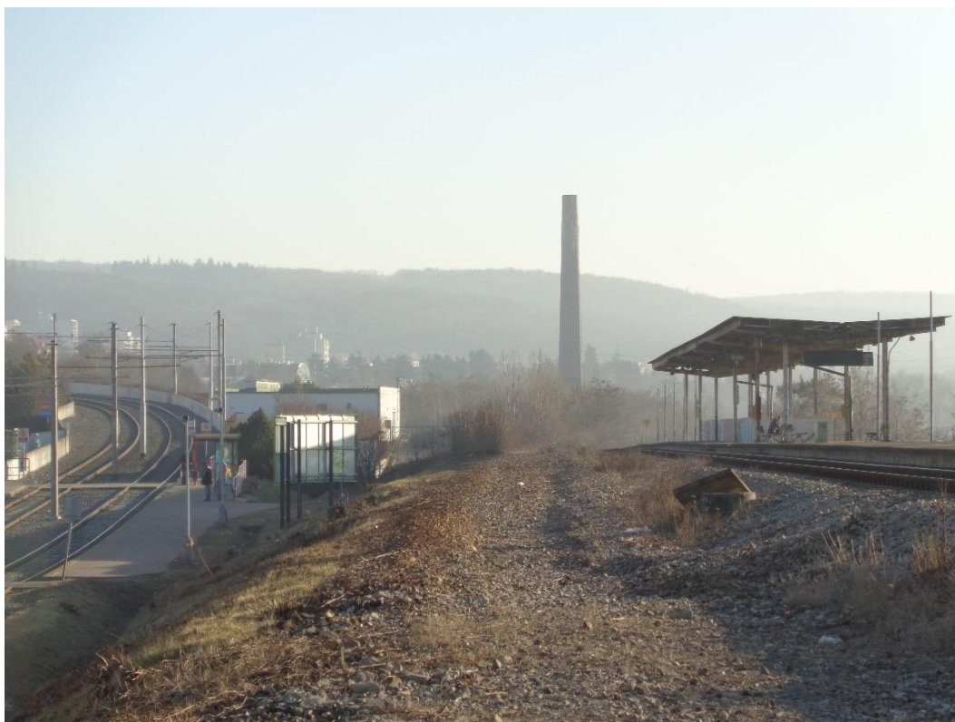
Obrázek 2 – Pohled na ostrovní nástupiště výhybny Praha-Modřany zastávka. Vlevo zastávka tramvajové trati směr Sídliště Modřany. V pozadí komín umístěný ve zdemolovaném areálu modřanského cukrovaru. Fotograf stojí na pláni tělesa železničního spodku snesené vlečkové koleje V1144 NESTLÉ Čokoládovny a.s., závod ORION
