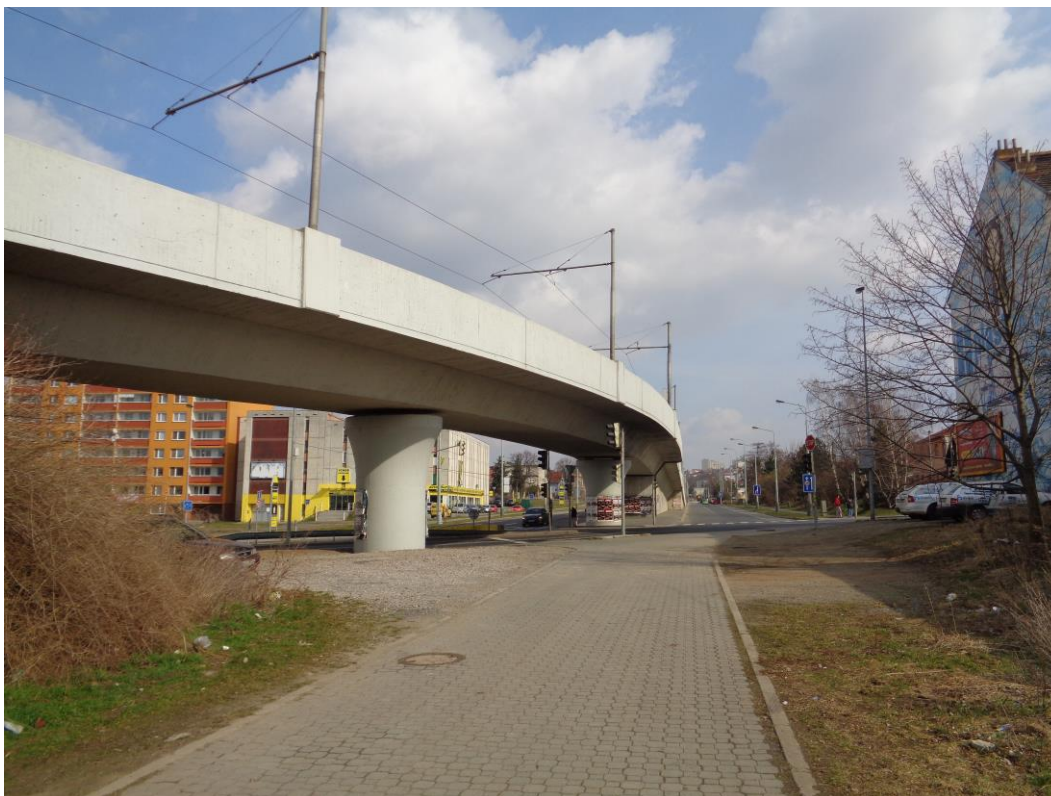
Obrázek 6 - Pohled směr křižovatka Modřanská × Komořanská × Generála Šišky z ulice U Spořitelny
