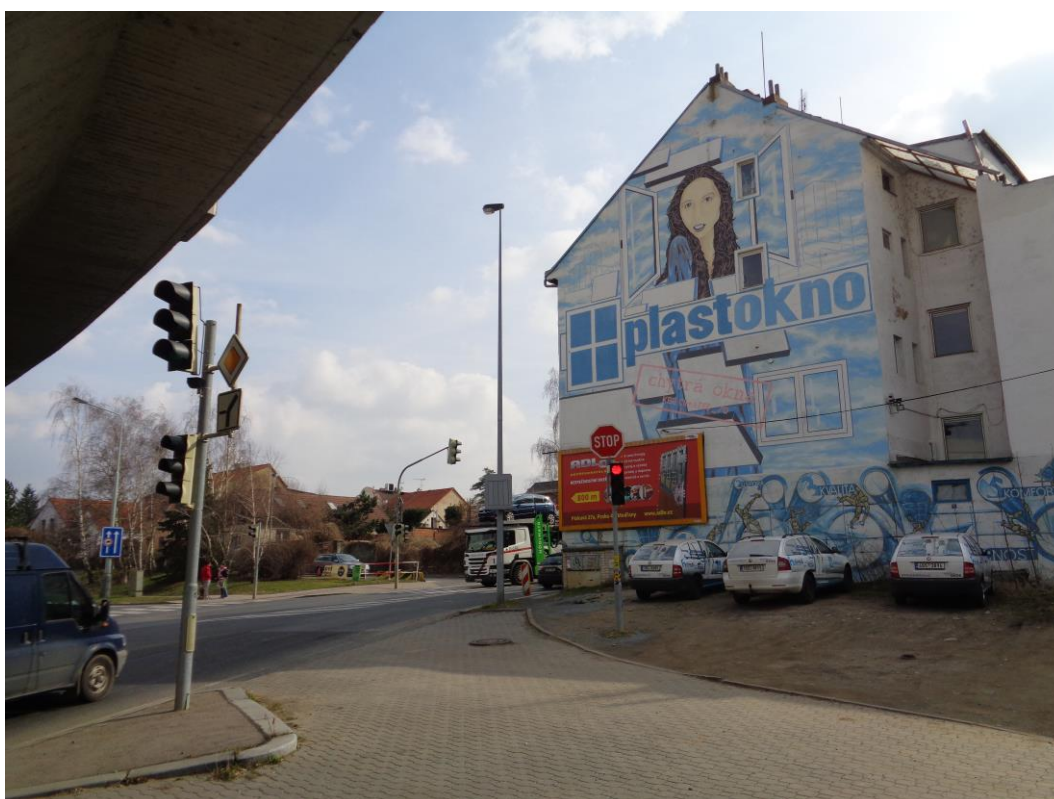
Obrázek 7 - Obytná budova, která ustoupí rozšíření Komořanské v rámci KPMČ a proběhné u ní demolice. Tramvajová trať bude odbočovat vpravo (směr nákladní automobil)
