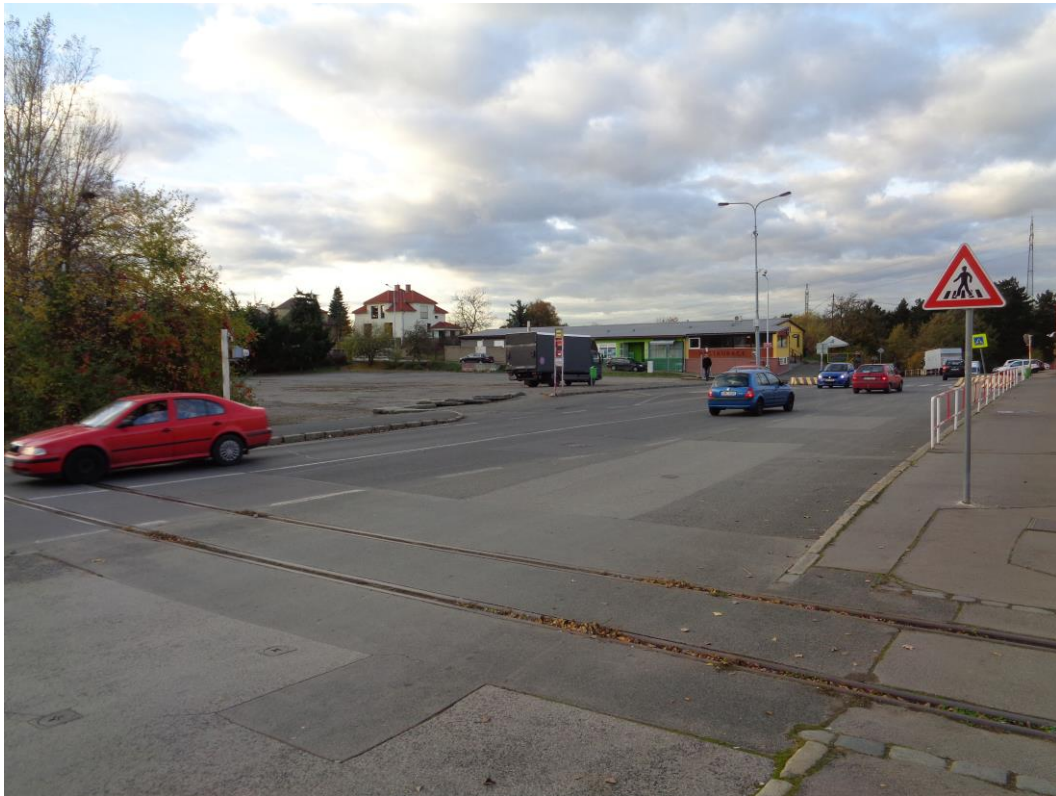
Obrázek 17 - Podoba komunikace Komořanská v místě železničního přejezdu s vlečkou MOSTRO. Pohled směr Modřany
