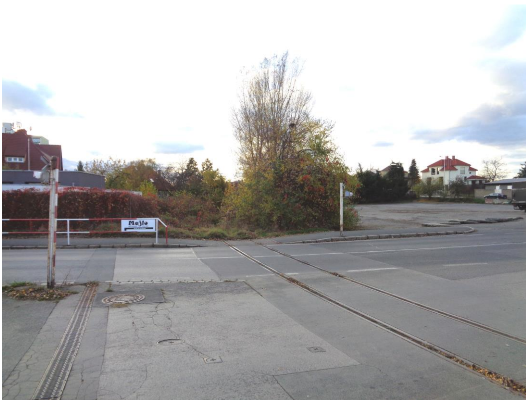
Obrázek 27 - Před křížením s komunikací Komořanská se nalézá zastávka Komořanské náměstí. Pozemek vpravo dříve sloužil jako odstavňá plocha pro automobily zaměstnanců Modřanských strojřren. Inženýrské sítě jsou v místě přejezdu vedeny kolmo vzhledem k vlečkové koleji a uloženy v chráničkách
