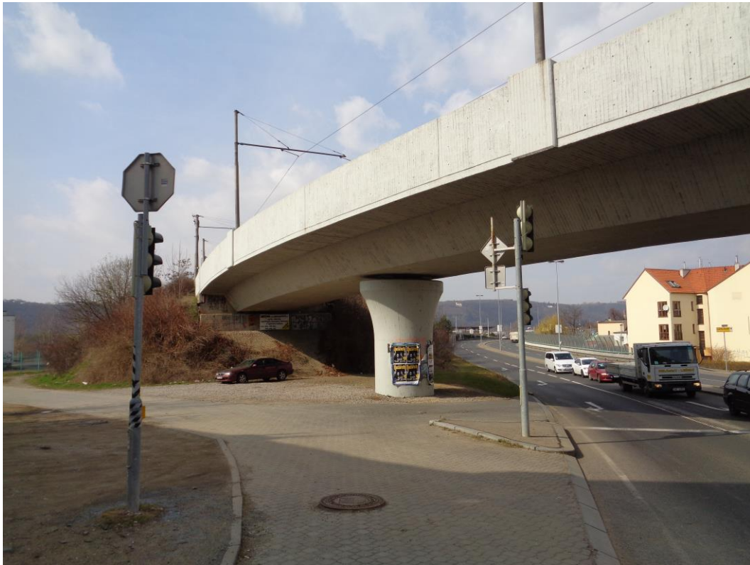
Obrázek 10 - Celkový pohled na řešenou křižovatku. Vlevo vyústění ulice U Spořitelny, vpravo koncová část komunikace Modřanská, za zády fotografa Komořanská
