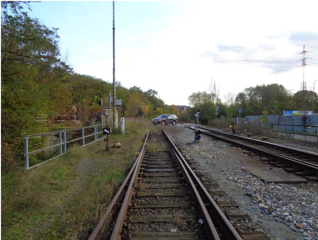
Obrázek 21 - Pohled na železniční přejezd P5726 převádějící přes železniční trať komunikaci U Soutoku. Kolej vpravo je dopravní koleji ŽST Prahy-Modřany směr Praha-Zbraslav. Fotograf stál v prostoru manipulační koleje ŽST a právě výhybkou této manipulační koleje začíná staničení vlečky MOSTRO V1037. Kolej vlevo je vlečková kolej EŽ Praha, a.s. – Praha Modřany
