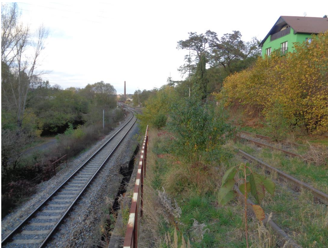
Obrázek 23 – Fotograf se nalézá na hraně opěrné zdi vlečky MOSTRO. Pohled směr ŽST Praha-Modřany. Úsek Nové Komořanské využije původní stopu železniční trati. Tramvajová trať bude v místě fotografie vedena přibližně ve stejné stopě jako vlečková kolej umístěná více vpravo.
