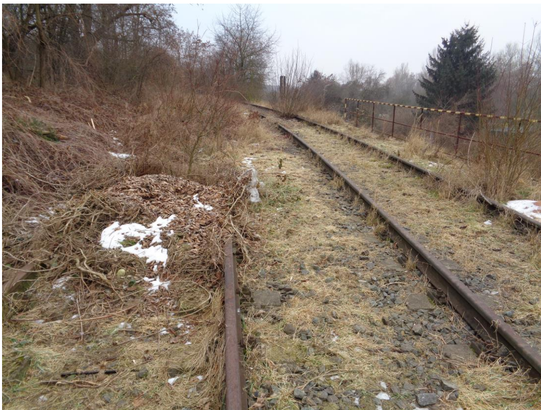
Obrázek 24 - Přibližně ze stejného místa jako předchozí fotografie, ovšem opačným směrem vznikla fotografie, na níž je patrná kolej vlečky MOSTRO (vlevo) a kolej do teplárny (vpravo).
