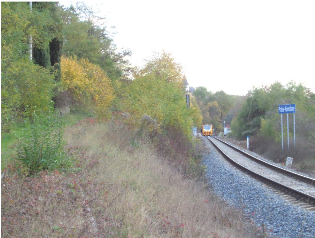
Obrázek 22 - Těleso vlečky MOSTRO za přejezdem stoupá a vzdaluje se koleji železniční trati SŽDC č. 210. Na snímku je patrné vjezdové návěstidlo ŽST a návěstidlo vyjadřující návěst Konec posunu. Motorová jednotka řady 814+014+914 zastavila v zastávce Praha-Komořany
