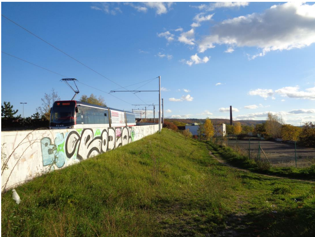
Obrázek 5 - Kolej 1 klesá z náspu ke křižovatce Komořanská × Modřanská × Generála Šišky × u Spořitelny
