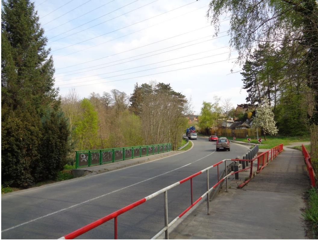
Obrázek 15 - Úsek Komořanské (směr Komořany) v místě křižování s korytem Cholupického potoka
