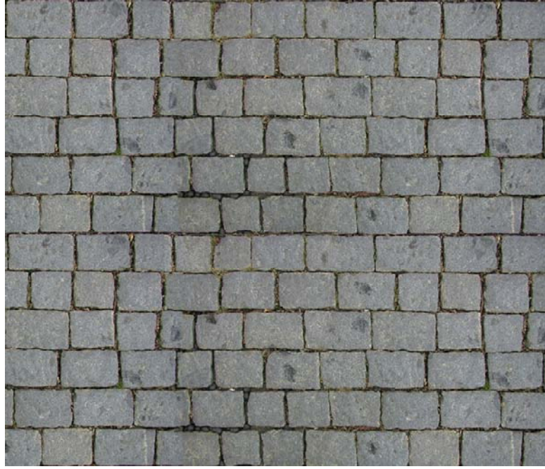
VELKÁ ŽULOVÁ KOSTKA DO ŘÁDKŮ parkovací pruhy a stání označení ve výkresu P2
