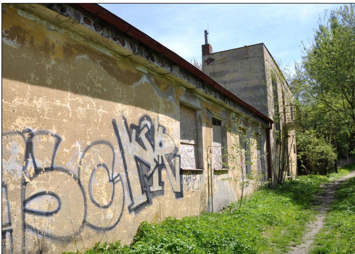
Obrázek 10 - Objekt provozní budovy, boční pohled (zdroj: autor práce)
