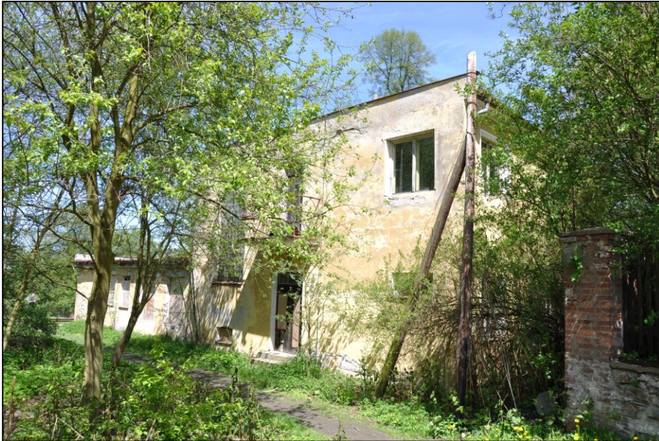
Obrázek 11 - Objekt provozní budovy, pohled od příjezdové cesty (zdroj: autor práce)
