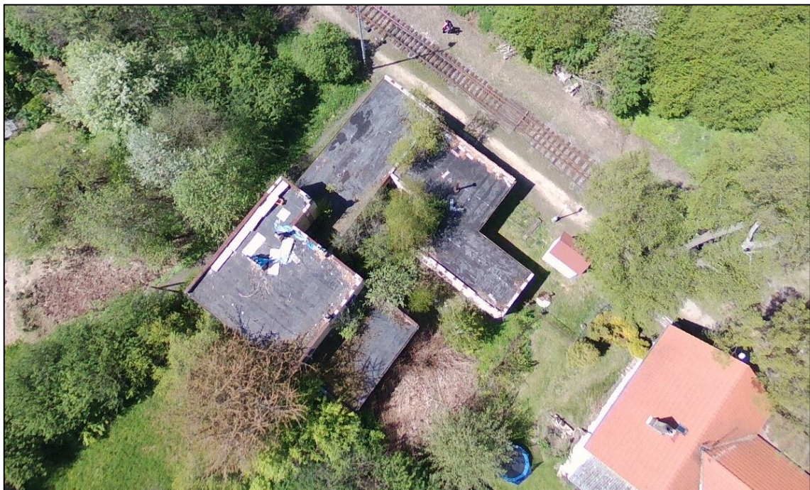
Obrázek 5 - Objekt provozní železniční budovy, pohled shora (zdroj: autor práce)
