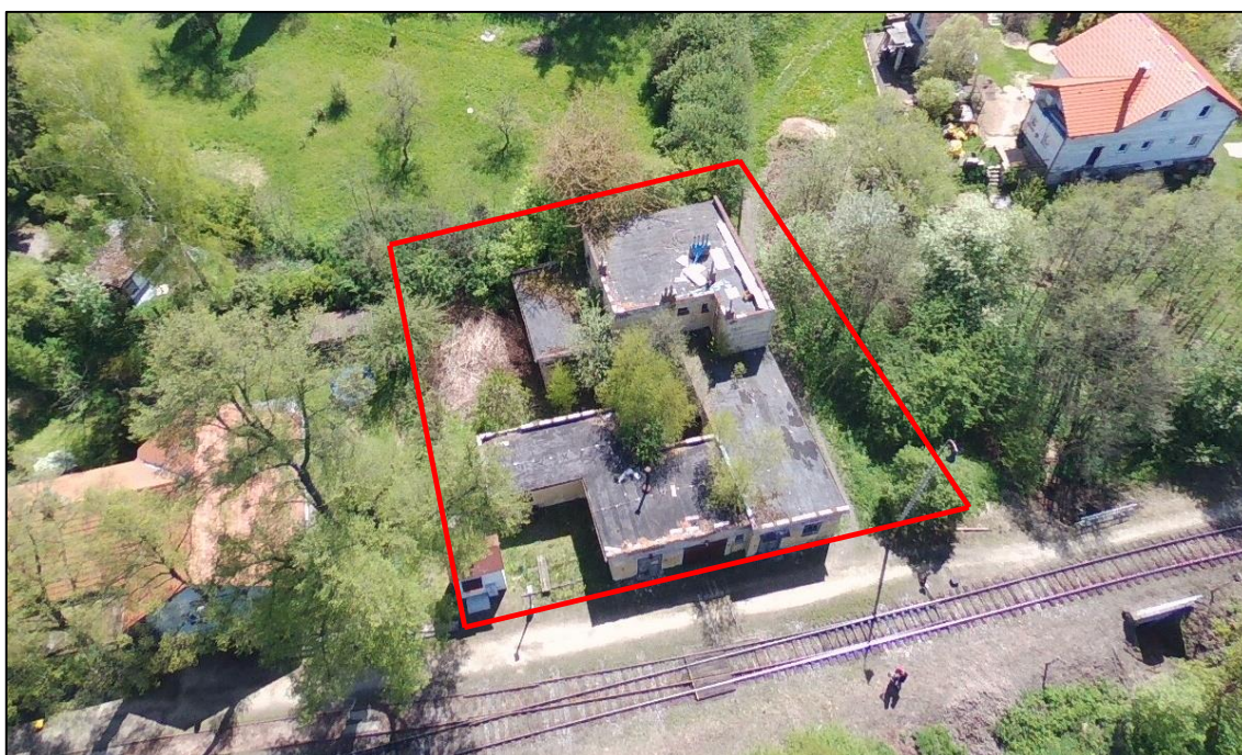
Obrázek 8 - Objekt provozní budovy trat'ového okrsku žst. Zbraslavice (zdroj: autor práce)
