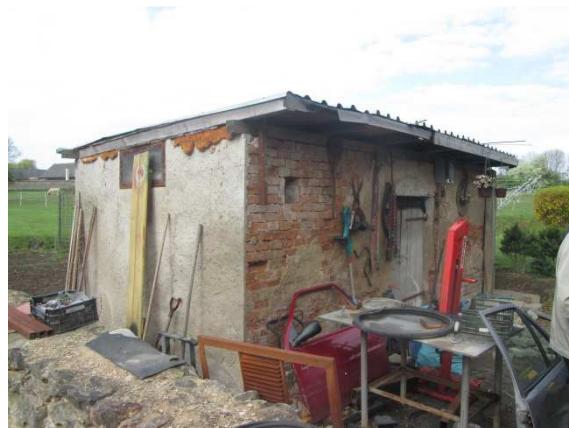
Obr. 3 – Přístavek stojící nad garáží
