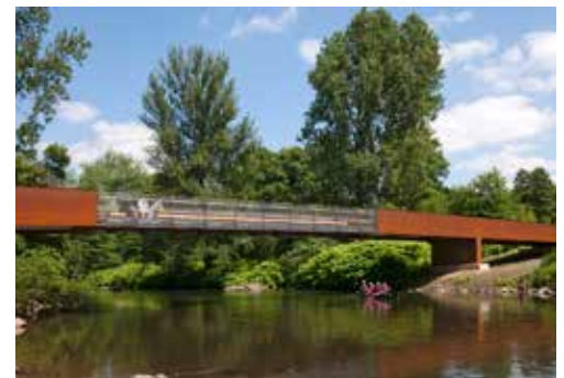
Agirbas & Wienstroer Opladen, district of Leverkusen, Germany Wupper-Bridge Opladen
