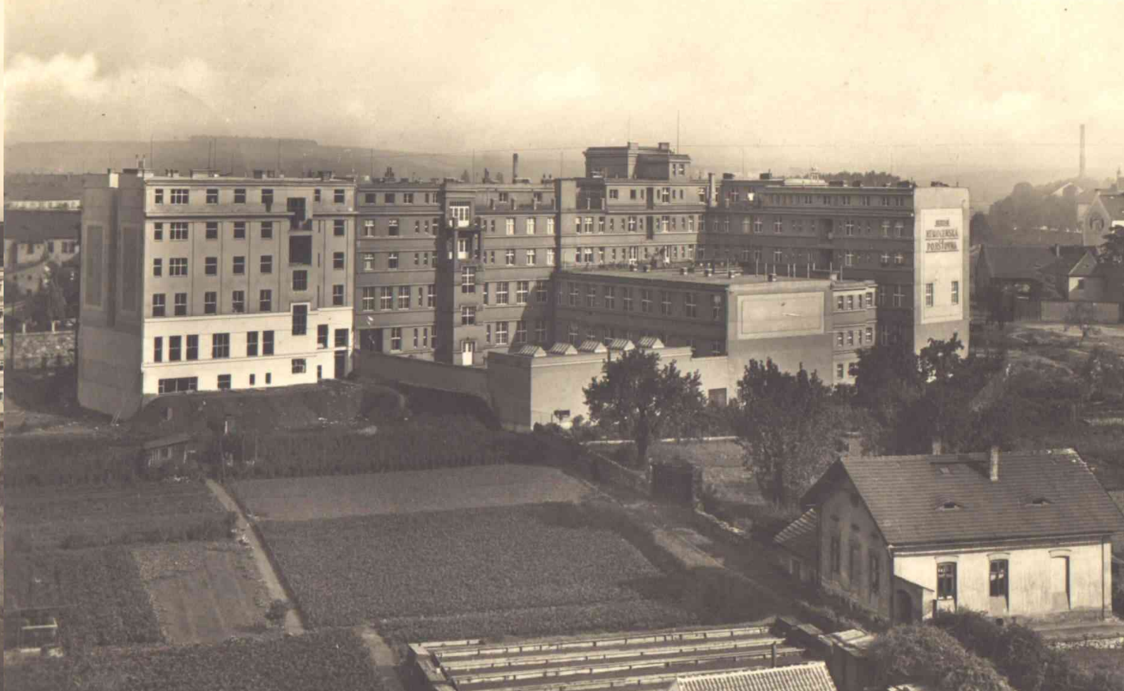
Budova polikliniky, pozemky a budova zahradnictví, 20. léta 20. století
