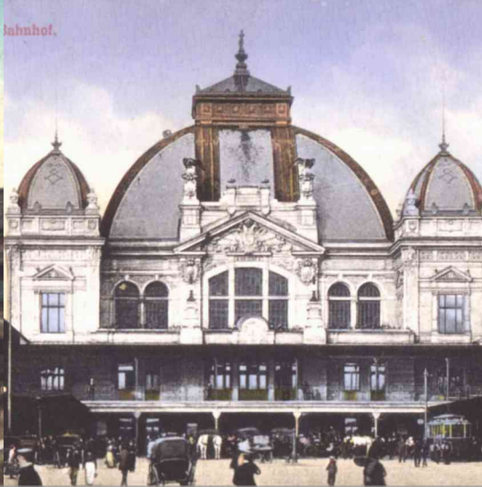
Budova hlavního nádraží, 1912
