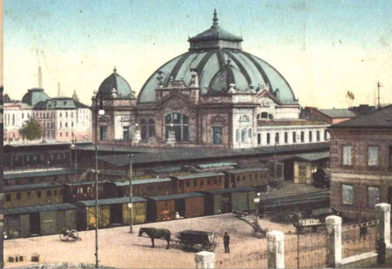
Budova hlavního nádraží, 1913
