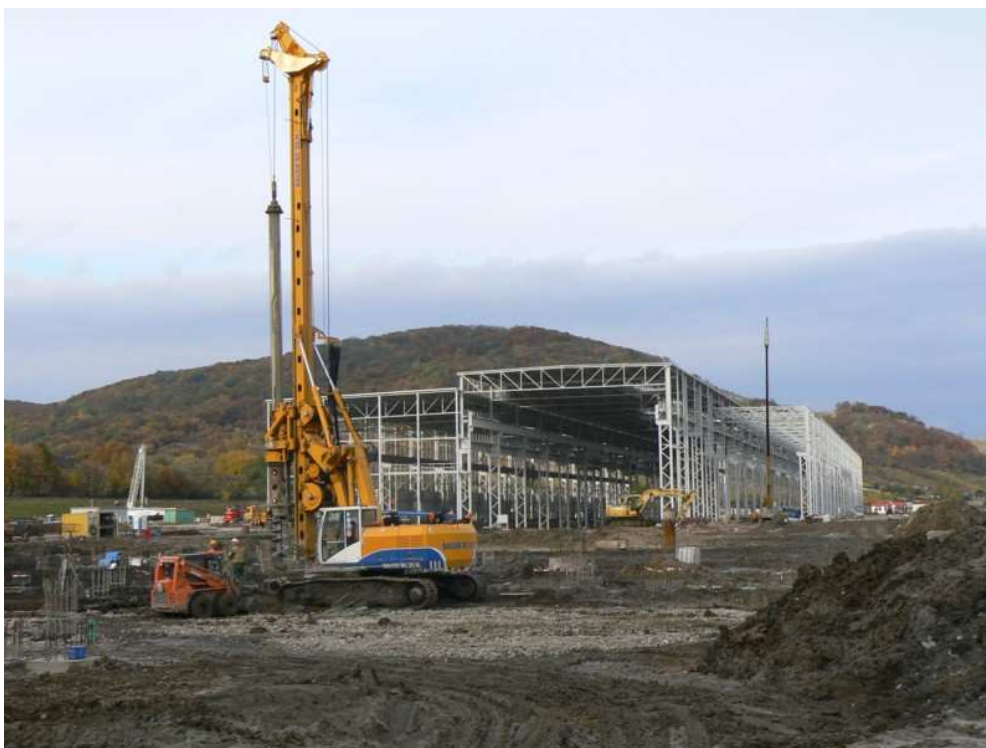
Obr. 6.6 Provádění vrtaných pilot ve Strážském [Čeněk a Ježek]
