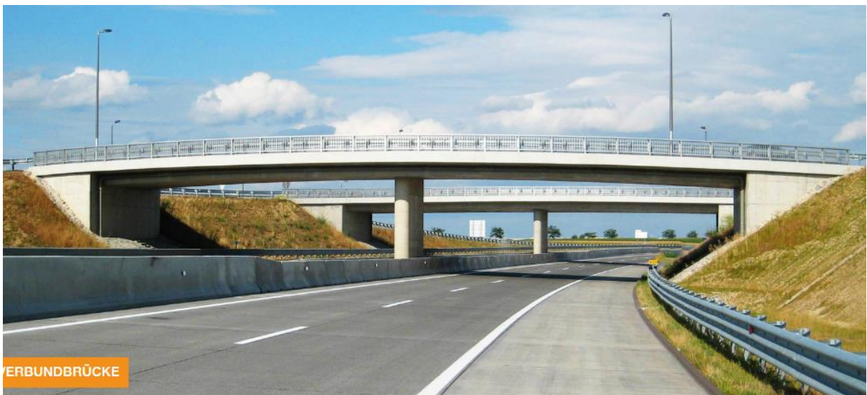
Obr. 2: Integrovaný most Verbundbrücke na dálnici A6, Německo
