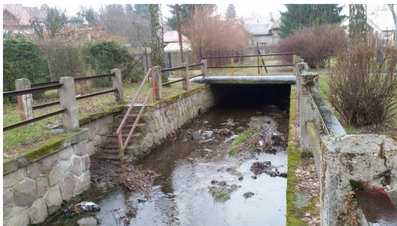
Obrázek 22. Blahovský potok ř. km 0,133 v místě zakrytí toku, fotografie proti proudu, 19.3.2017
