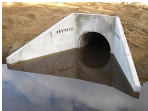
Obr. 17 Typický vtok do propustku: svislá čelní stěna a sklopené boční stěny
