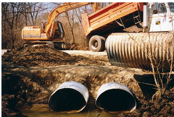
Obr. 21 Typický vtok do propustku: předsazený vtok
