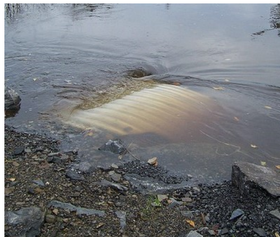
Obr. 9 Zatopený vtok během povodní; viditelná tvorba víru
