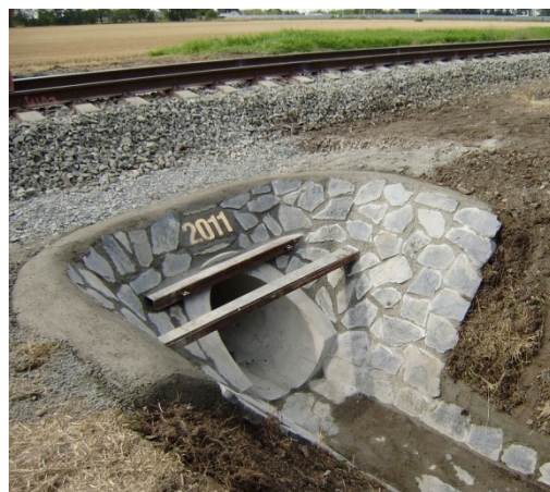
Obr. 18 Typický vtok do propustku: vtok zarovnaný se svahem (šikmé čelo propustku)
