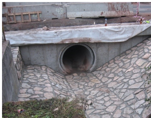
Obr. 20 Typický vtok do propustku: kolmá čelní stěna
