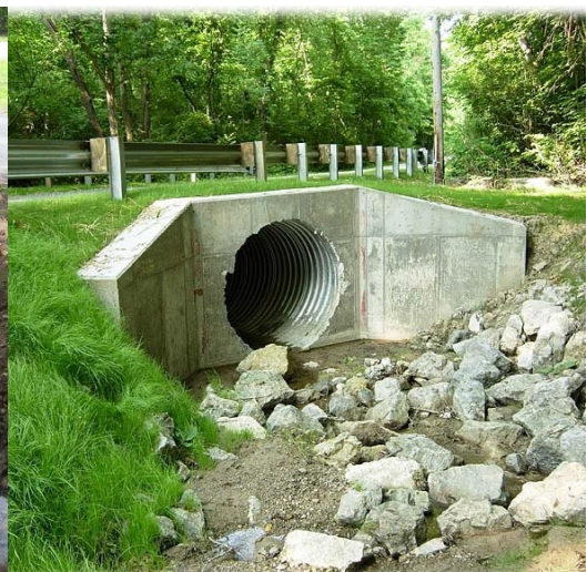
Obr. 2 Typický propustek z vlnitého plechu kruhového profilu s betonovou čelní stěnou a bočními křídly
