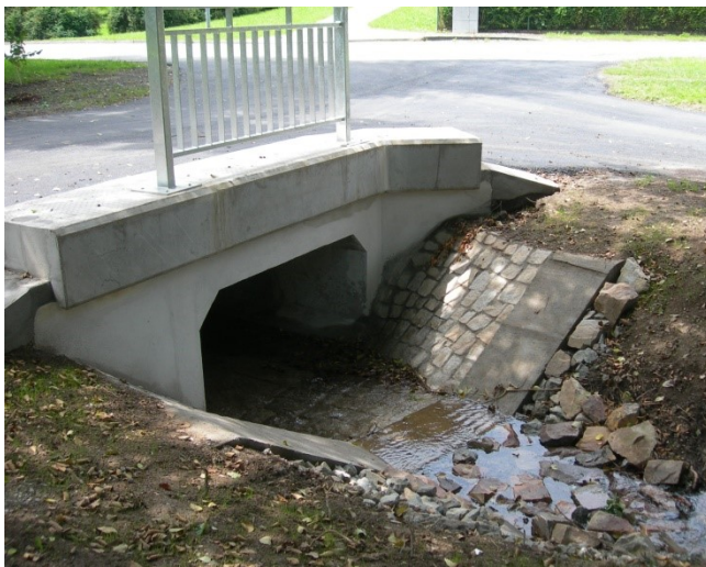
Obr. 1 Typický betonový propustek obdélníkového profilu
