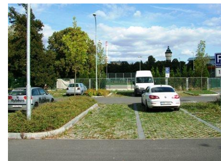
054 Jako alternativní povrch může pod parkujícími automobily sloužit kamenná dlažba se zatravněnou spárou (Plzeň).
