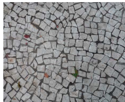
016 Nepravidelná dlažba ze štípaných žulových kostek.
