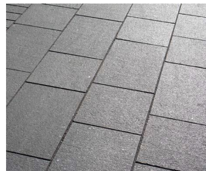
020 Velkoformátovou žulovou dlažbu lze využít jako povrch pro pěší i v historické části města.
