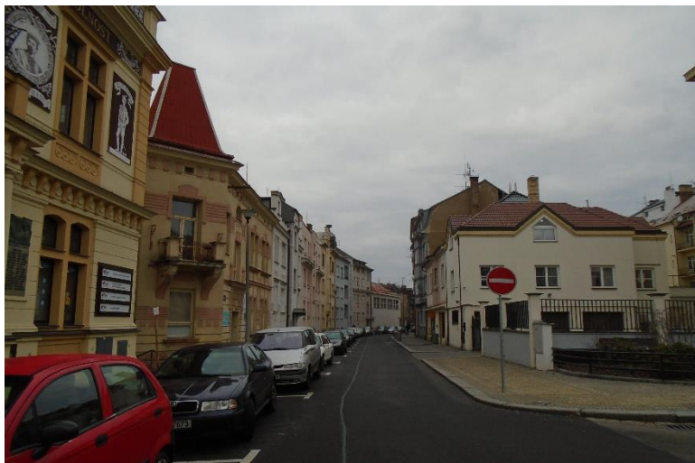
085 V ulici Farského není díky šířce uličního profilu umožněna výsadba stromořadí.
