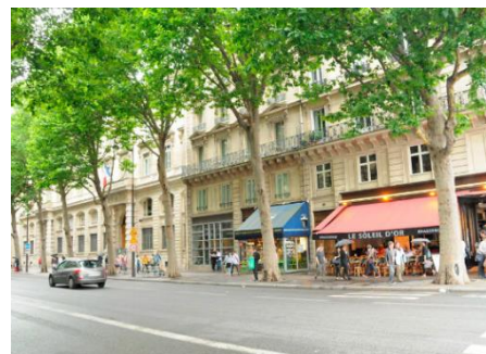
089 I velké stromy lze umístit v těsné blízkosti fasády domů. Je ale potřeba jim dát odpovídající péči (Francie, Paříž).
