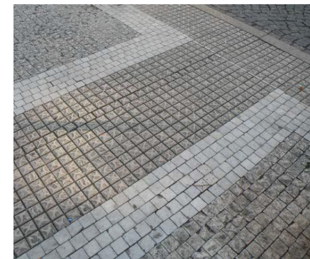
029 Dlažba s výstupky pravidelného tvaru je vhodným řešením do začlenění v historickém jádru.
