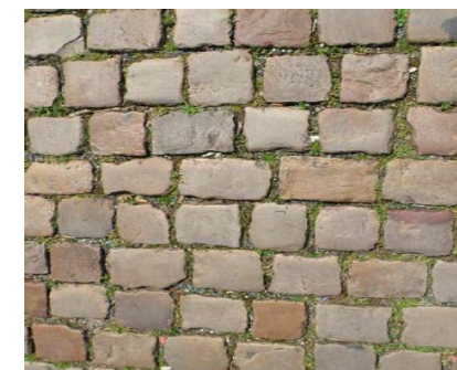
019 Křemencová dlažba velkého formátu (využití pro vozovky v historické části nebo ve sdílených prostorech).
