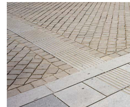
031 Způsob umístění vodící linie na přechodu pro chodce.
