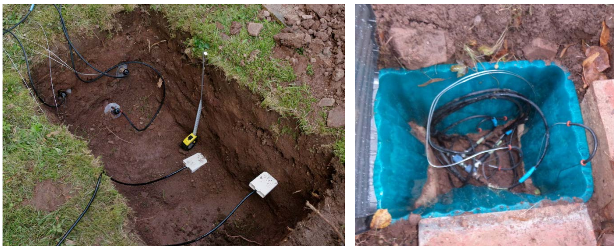
Obrázek 11 - Detail šachty po instalaci čidel (vlevo) a po „vystrojení“ (vpravo)
