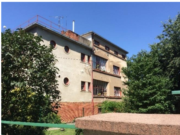
Obrázek 3 - Pohled z východní strany, (foto autor)
